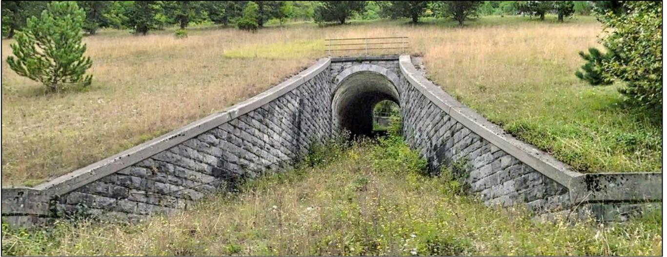
Le passage sous le remblai-plate et la plate-forme de la voie ferrée n'est plus emprunté aujourd'hui, mais reste ouvert. Les murs latéraux courbes maçonnés sont impressionnants
