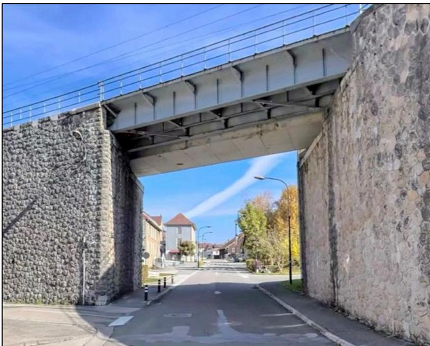
La vue actuelle, à gauche, montre la tête ouest du pont avec sa structure métallique d'origine pour une partie du pont (demi-tablier).
