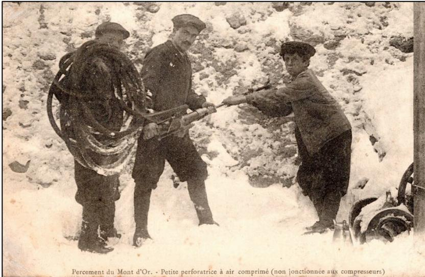
Percement du Mont d'Or. - Petite perforatrice à air comprimé (non jonctionnée aux compresseurs)
