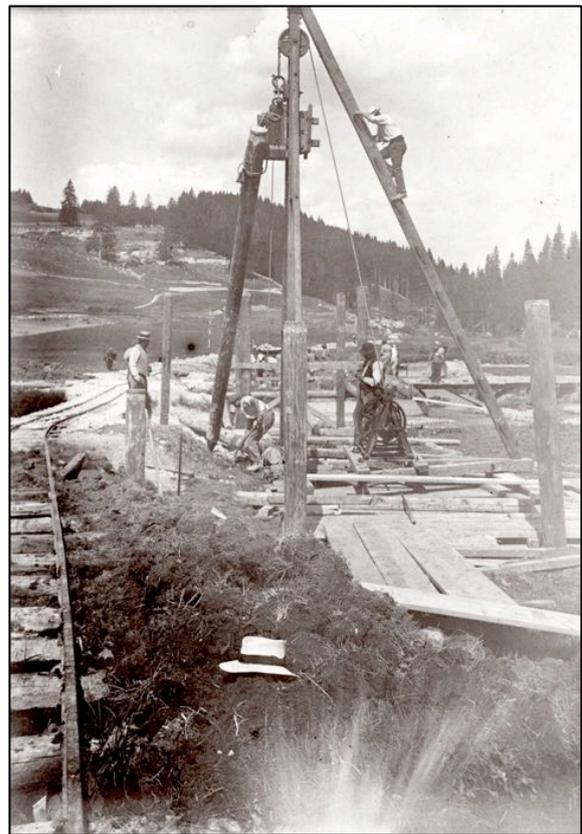
C'est surtout sur le chantier de construction des ponts des Longevilles-Rochejean que l'on va recourir intensément aux chèvres pour battre des palplanches (et les retirer).
