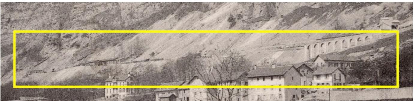
À noter sur la droite, l'estacade maçonnée à neuf arches. Servant à supporter, renforcer et stabiliser la plateforme sur laquelle passeront les convois ferroviaires, elle sera ultérieurement engloutie par et dans le remblai comme le seront aussi les monumentales fondations de la nouvelle gare.
