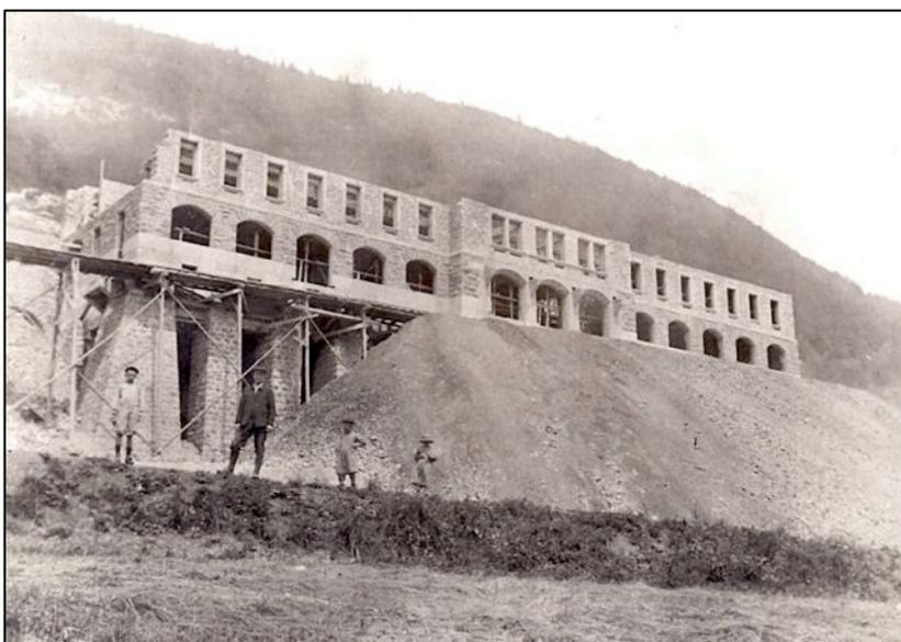
L'estacade servant à supporter le passage des voies principales de la nouvelle ligne et de leurs trains a disparu sous un important remblai continu menant au tunnel. C'est le cas aussi des puissantes fondations de la nouvelle gare aujourd'hui totalement invisibles.
