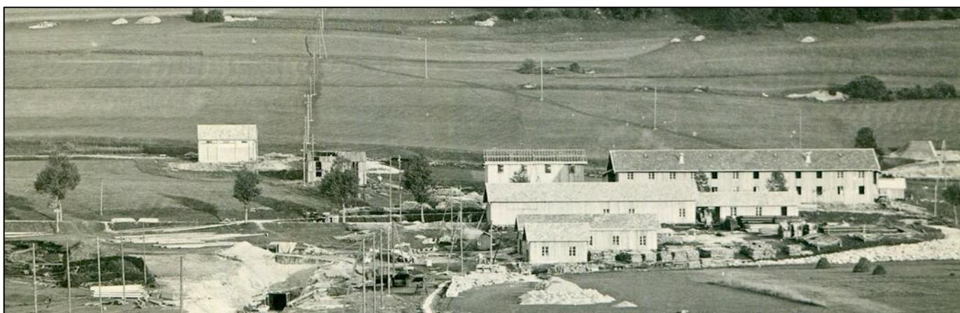
L'extrait ci-dessus d'un cliché Parreaux d'août 1911 permet de bien situer chaque ouvrage, équipement ou bâtiment dans l'espace et le temps. La galerie d'avancement du tunnel commence à être percée.
