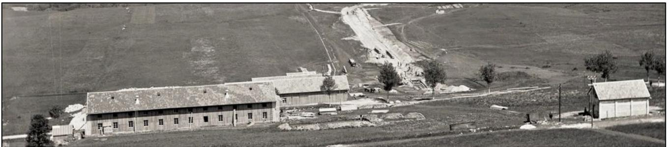
Sur le cliché Parreaux ci-dessus du 28 juin 1911, on identifie très bien, isolé et à droite, le bâtiment 15 de la zone A (transformateur). En zone B, le bâtiment 13 (magasins) est terminé et deux des trois bâtiments 11 (ateliers) sont déjà en fonctionnement. Au premier plan à gauche et en zone C, un premier et long bâtiment d'hébergement H1 est érigé.
