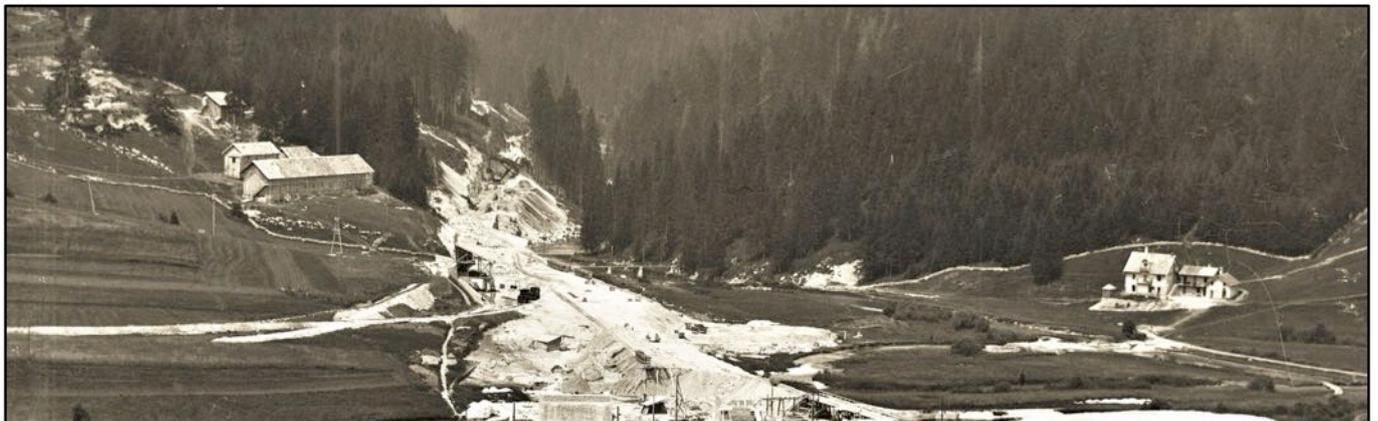
Une vue panoramique nouvelle d'Émile Parreaux, en date du 15 juillet 1912, montre l'avancement des travaux dans la tranchée du Mont de la Croix et l'achèvement de trois culées sur quatre des ponts des Longevilles. On peut voir, au passage, le concasseur, du chantier des Longevilles (entre tranchée du Mont de la Croix et ponts des Longevilles sur le Doubs).
