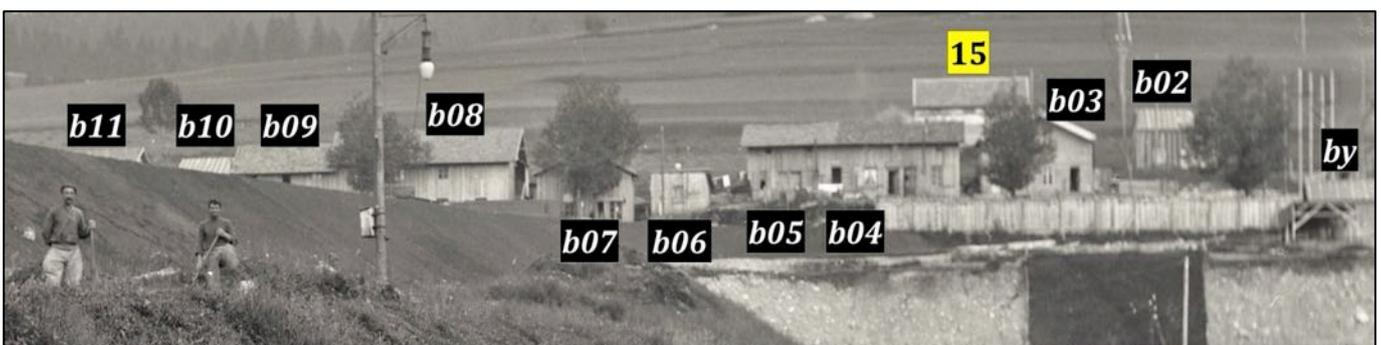
Dans le secteur occidental du "village éphémère", rien de nouveau en juillet 1913. La façade monumentale de la tête du tunnel n'est pas encore construite : on voit toujours le talus végétal soutenu en pied par une murette maçonnée au-dessus de la voûte du tunnel.
