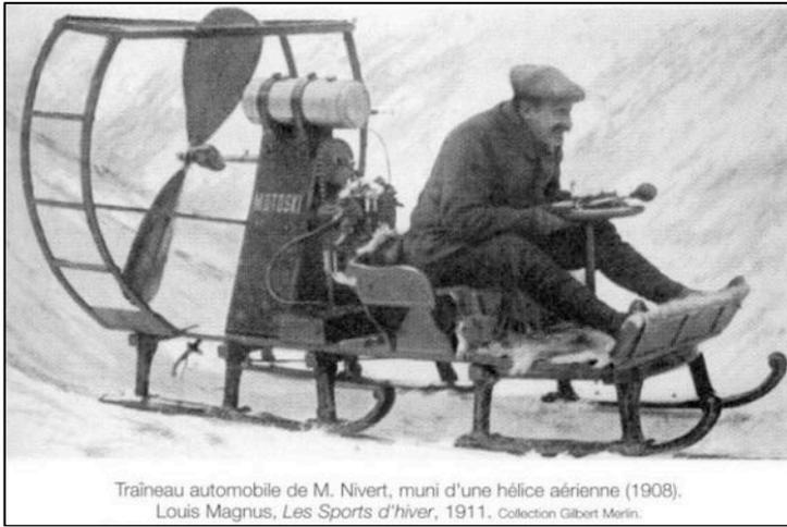
Au tout début du XX<sup>e</sup> siècle, Nivert se penche sur la conception et la construction d'un engin automobile pouvant se déplacer sur la neige avec des skis et propulsé par une hélice. Il dépose un brevet et se met à tester son engin.
