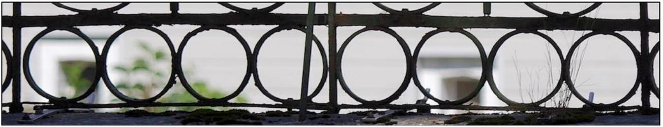
Il semblerait que les anneaux soient liés aux barres horizontales par de discrets rivets et soient par ailleurs soudés entre eux (possible renforcement tardif après 1940?).
