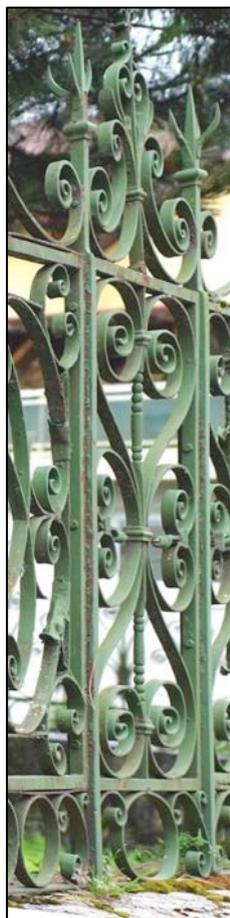
Les différents panneaux de la grille sont constitués, structurellement, de cadres en fer de section carrée fixés par boulonnage sur des fers-poteaux verticaux scellés dans le soubassement en pierre (et en béton).
