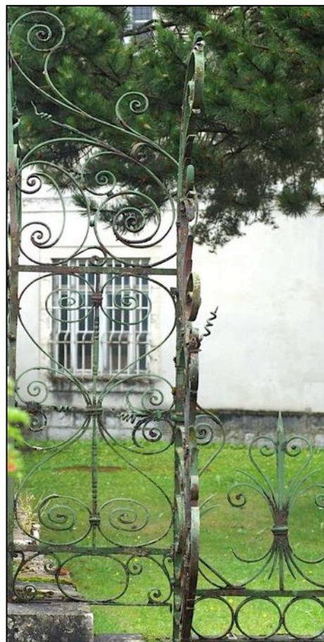
La fixation par étrier boulonné du "garde-cocu" sur le montant vertical du panneau pi8 semble moderne (réalisation sans doute après la reconstruction du pont de la grille après 1940).
