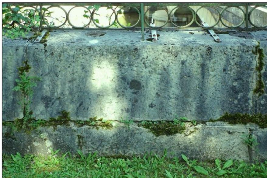
La grille est établie et scellée sur un muret en très gros blocs de pierre appareillés, comportant deux assises de blocs au-dessus du mur de soutènement dominant le Doubs.
