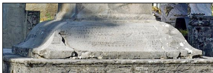
La doucine inversée du socle sur légère plinthe
