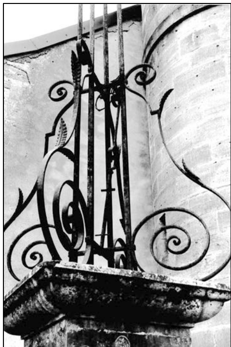
Ailerons métalliques liant le fût au piédestal (C1. CRMH - PB - 1991)
