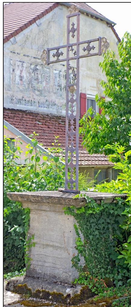
***Croix en fer forgé non datée, à structure 2D en fer et remplissage à motif en fonte moulé***
