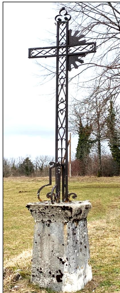
***Croix en fer forgé à structure 3D (base) et 2D et décor de remplissage de ferronnerie.
