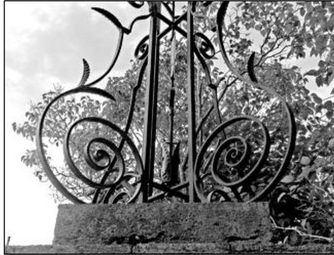
Des duos de feuilles d'eau nervurées en tôle estampée sont soudés aux consoles au sortir des gros rouleaux. D'autres feuilles sont placées au niveau des redans, dirigées vers l'extérieur et vers le haut.
