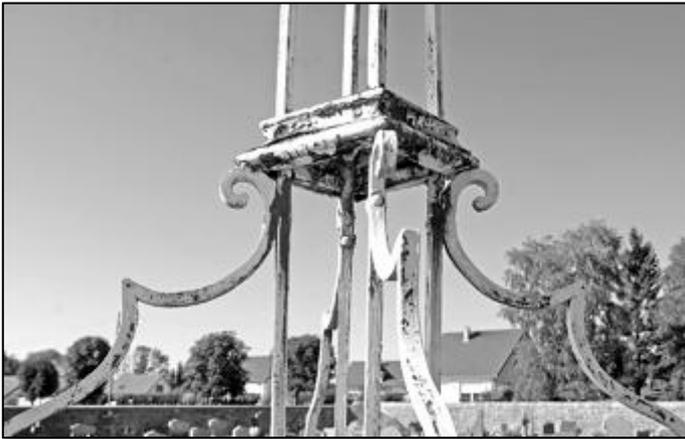
Au-dessus des consoles, a été positionnée une structure ou plate-forme intermédiaire pleine, avec des moulures, à partir de laquelle partent les quatre fers verticaux de la seconde partie du fût. Il n'y a pas continuité de structure des fers verticaux, pas plus que de torsion à 45° de ceux-ci. La plate-forme vient ici gérer la discontinuité structurelle.
