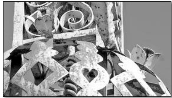
À noter que le globe, très élégant, occulte l'endroit où les profils des montants verticaux changent d'orientation (torsion à 45%) pour se mettre parallèles aux faces du piédestal. Le travail du fer et de la tôle de fer est ici d'une qualité remarquable.
