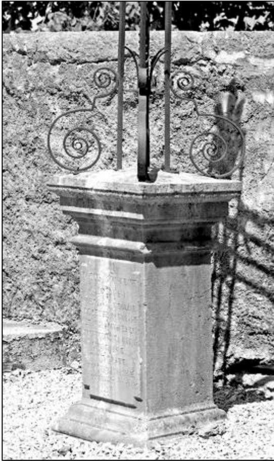
De forme globalement parallélépipédique, le piédestal en bon calcaire ne présente pas d'emmarchement visible. On devine une possible moulure.
