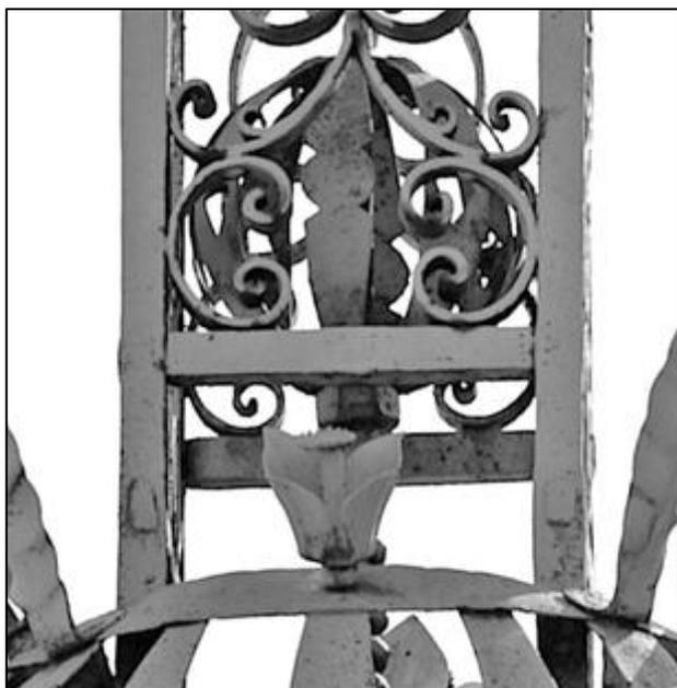
Dans le bas de la “cage” (partie supérieure du fût) a été disposé un second globe, plus petit que le globe majeur et fixé par boulonnage à la tige-rameau torsadée. Il est malheureusement difficile de distinguer ce que ce petit globe contient.
