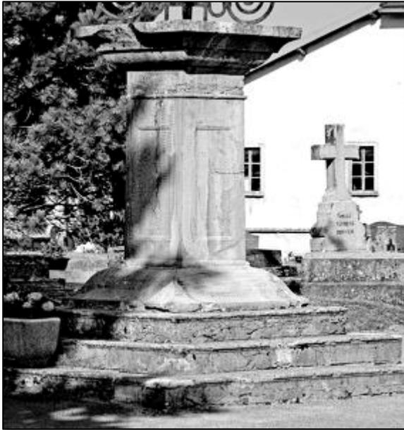
Le piédestal repose sur une base ou emmarchement de dalles calcaires rectangulaires (trois marches avec rebord). Chacune des trois marches présente un nez avec moulures saillantes (tore semi-circulaire au dessus d'un réglet). L'effet de la lumière et des ombres sur cet emmarchement en accentue la qualité.
