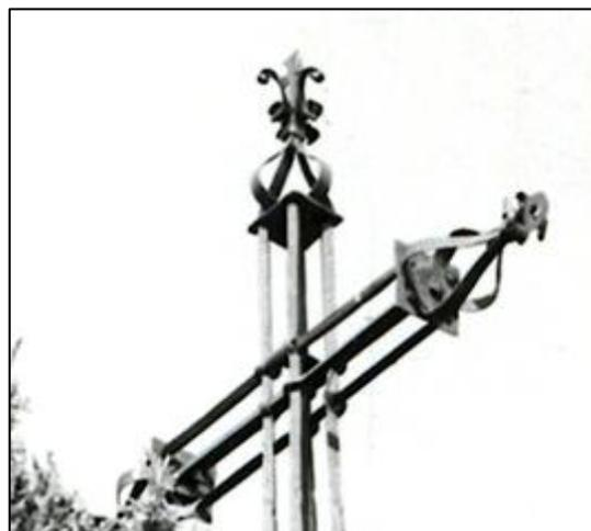
Au dessus du globe, quatre montants verticaux s'élançant vers le haut : les fers de section carrée ont les plans de leurs faces orientés selon la diagonale du piédestal. Après une plaque de fer intermédiaire formant entretoise et servant à rigidifier la structure, les fers verticaux continuent vers le haut sans changer l'orientation de leurs profils. À noter le travail de ferronnerie réalisé pour permettre le passage des barres verticales à travers les barres horizontales.
