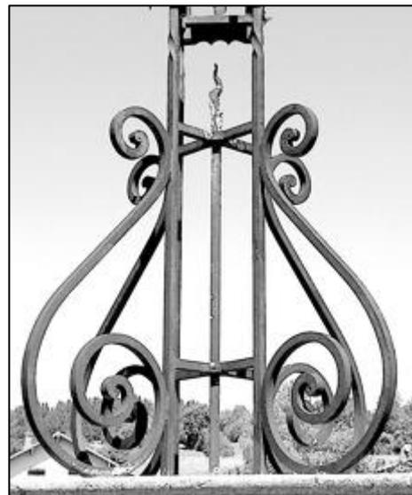
Une tige verticale en fer forgé passe par les centres des croisillons. Elle se termine par une forme en flamme ondulante. À noter qu'à ce niveau, les fers montants subissent une torsion bien visible de 135° (soit 90+45, solution originale et rare) pour que leurs faces redeviennent parallèles à celles du socle.
