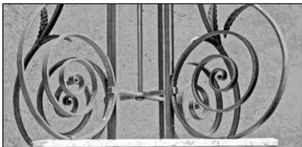
Les consoles sont fixées par boulonnage aux fers des montants verticaux du fut. L'assemblage se fait au niveau de deux croisillons d'entretoisement. Les fers ascendants ont alors leur faces orientées selon les diagonales du fût.
