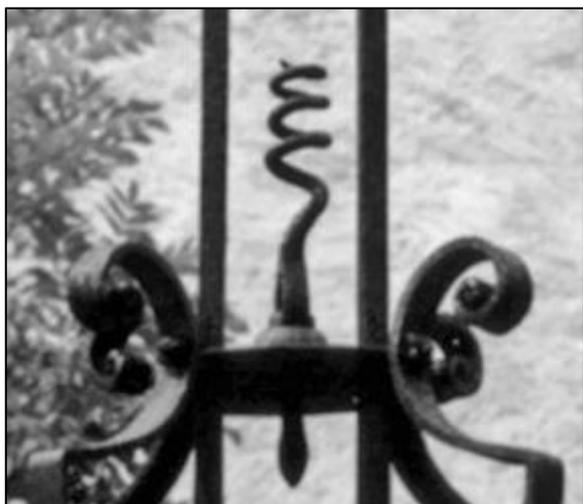
Les montants verticaux sont, eux, réalisés en fer de section carrée.
