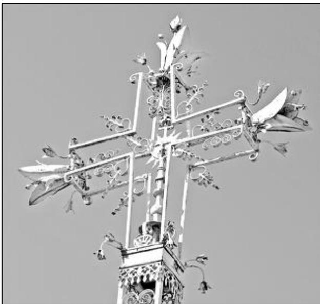
Les trois extrémités libres de la croix se terminent, à l'extérieur, par de très grosses fleurs de lys nervurées en tôle étampée, assez sophistiquées, avec graines saillantes (quatre par fleur) séparées par des cloisons de tôle au sein d'un dispositif bien compartimenté.
