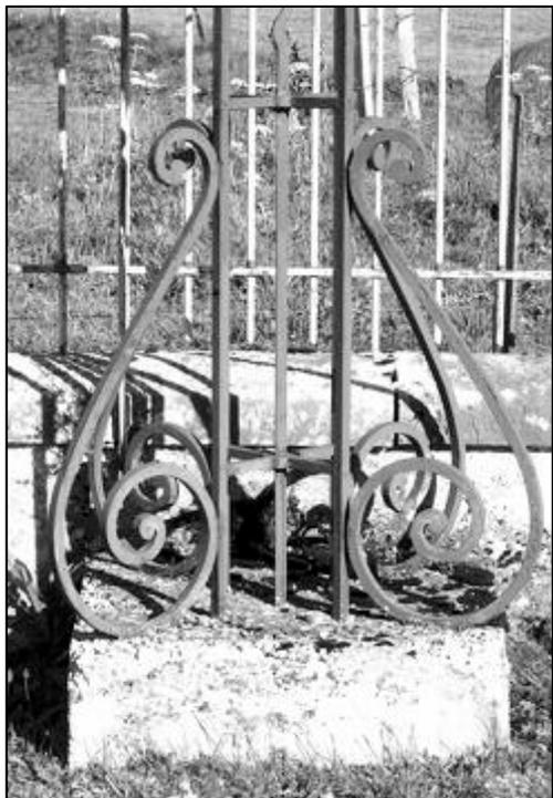
Quatre consoles assez lourdes, sans décor de tôle ajouté, sont orientées selon les diagonales du socle en béton et s'appuient sur les montants verticaux du fût. Les faces des fers de ces montants sont orientées comme les consoles, de façon à permettre une fixation facile.
