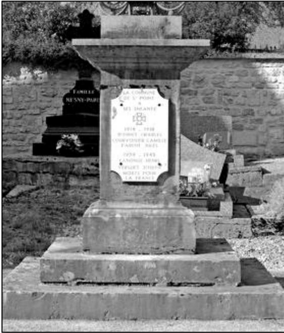
Le piédestal en calcaire, en quatre parties, repose sur une base ou emmarchement de dalles calcaires rectangulaires. Il comporte :
