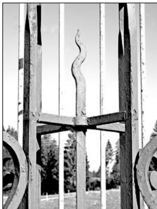
Une tige verticale en fer forgé passe par les centres des croisillons. Elle se termine par une forme en flamme ondulante. À noter qu'à ce niveau, les fers montants pivotent de 45° (contre 135° à Rochejean) pour que leurs faces redeviennent parallèles à celles du socle.
