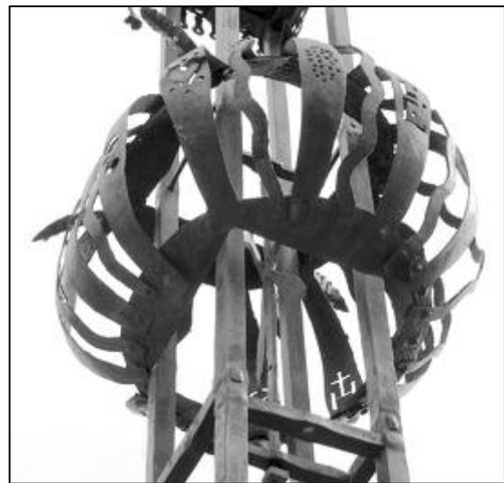
Le travail de ferronnerie mis en œuvre pour réaliser le globe et le motif chrismisque est remarquable avec une qualité de finition étonnante, comme en témoignent par exemple les subtiles assemblages par rivets.
