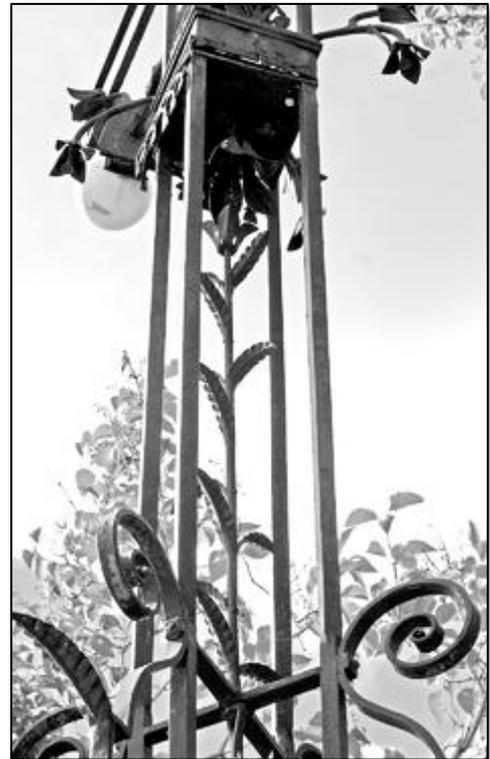
Les fers du fût montent jusqu'au niveau du dé métallique avec lambrequin. L'intérieur de cette partie supérieure du fût comporte un décor constitué d'une longue tige avec feuilles d'eau nervurées en tôle étampée se terminant par une petite corolle de lys. Cette tige prolonge l'axe décoré de la partie basse du fût, tout le décor du fût magnifiant ainsi le principe de verticalité.
