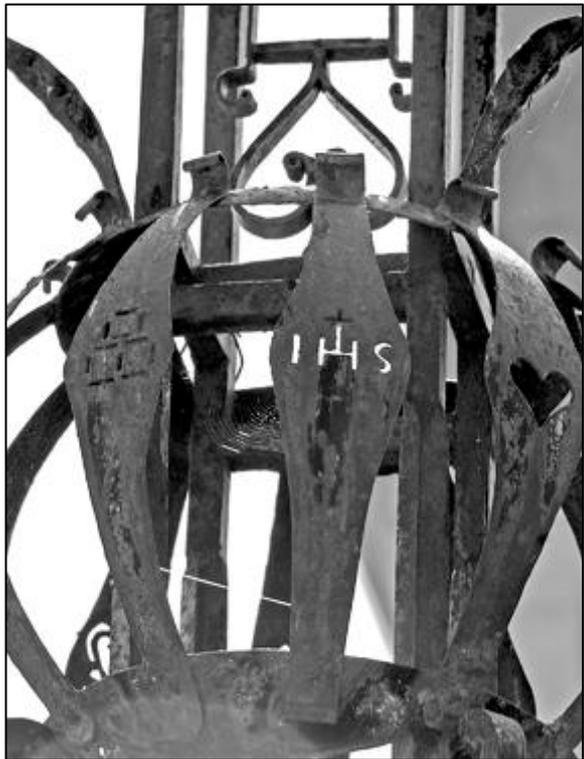
Quatre de ces segments cintrés sont prolongés vers le haut par des feuilles nervurées étampées. On notera aussi que le globe cache l'endroit où les profils des montants verticaux changent d'orientation (torsion à 45%) pour se mettre parallèle aux faces du piédestal (avec des entretoises de contreventement cachées par le globe).
