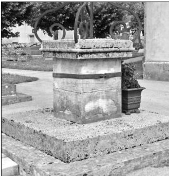
Le premier degré de l'emmarchement est en calcaire. Lui a été superposé un second degré en béton cellulaire.
