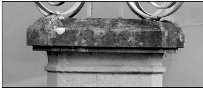
Les consoles en fer sont fixées sur la corniche dans les angles non évidés de celle-ci. Le travail de la pierre est ici assez complexe, facilité par l'emploi d'un matériau s'y prêtant.
