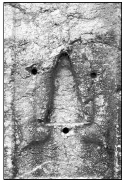
À noter les moulures verticales dégagées dans les quatre angles du corps du piédestal (sortes de colonettes engagées).
