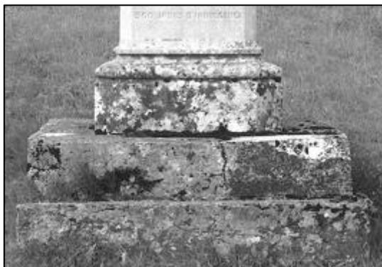
La croix étant placée sur un terrain pentu, une marche a été disposée en aval de la pente.
