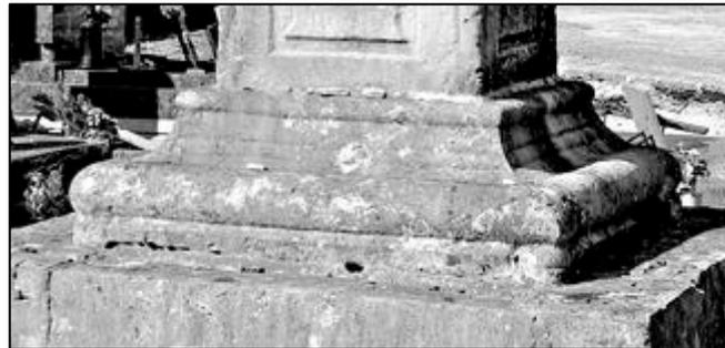
Les faces du corps comporte des panneaux dégagés en creux dans la masse du calcaire du piédestal. Les panneaux sont ainsi sculptés en forme de "tables de la loi" avec deux demi-cercles en partie supérieure formant bande lombarde et un cœur suspendu. Chaque panneau comporte un cartouche à la base.
