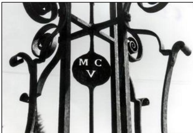
À l'intérieur du volume du fût créé par les quatre montants en fer forgé a été placée une tige, sorte de canne en bambou, avec (sous le croisillon) un renflement en tôle comportant, en découpe, les initiales M, C, V (dédicataire, commanditaire ?).
