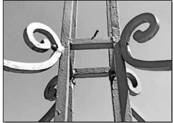
Les fers verticaux du fût ont leurs faces orientées parallèlement aux faces du piédestal et ne nécessitent donc pas de torsion à 45° à mi-hauteur du fût (comme c'est généralement le cas pour les croix anciennes), d'où la fixation des volutes dans l'angle des fers verticaux (dispositif de fixation forcément assez maladroit et fragile).
