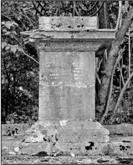
Le piédestal s'élève naturellement au-dessus de l'autel. Sa base (partie basse) est constituée d'un dé parallélépipédique lui-même surmonté d'un talon. La partie centrale du piédestal (le dé) est réalisée en deux blocs monolithiques superposés. Vient ensuite la corniche comportant d'abord une doucine, elle-même surmontée d'une sorte de scotie assez peu creusée. Un dernier dé parallélépipédique repose sur la corniche : les fers de la croix sont fixés sur ce dé.
