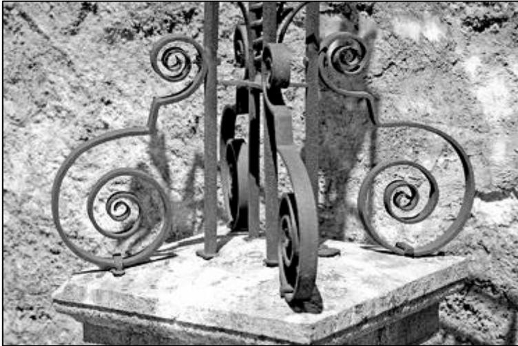
Dans la partie basse ferronnée, quatre fers de section carrée s'élèvent verticalement à partir de la surface supérieure bombée du piédestal. À noter l'orientation des profils des fers selon les axes diagonaux du socle.
