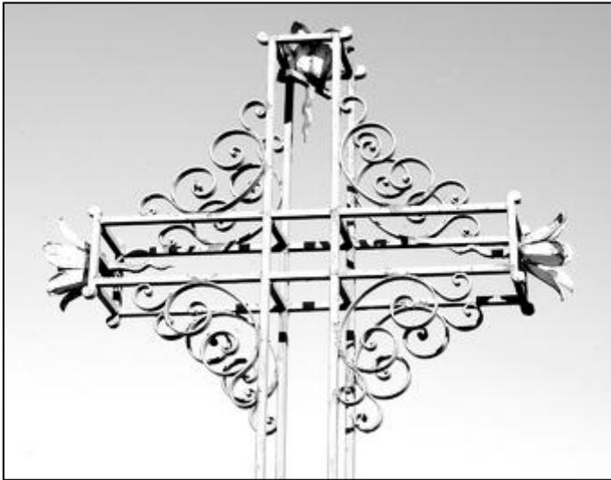
Cette partie "richement" ornée de la croix est basée sur un assemblage de fers horizontaux et verticaux assurant la non-déformation de la structure.
