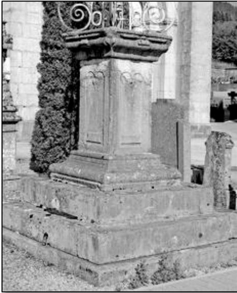
Le piédestal, repose sur une base ou emmarchement de trois dalles dont deux en calcaire et la plus basse en pierre cimentée, avec une petite moulure. Il est probable que ce puissant emmarchement constitué de beaux blocs calcaires simples ait pu avoir été créé lors du repositionnement de la croix après 1862-63 (cf. la différence de matériau entre les marches).
