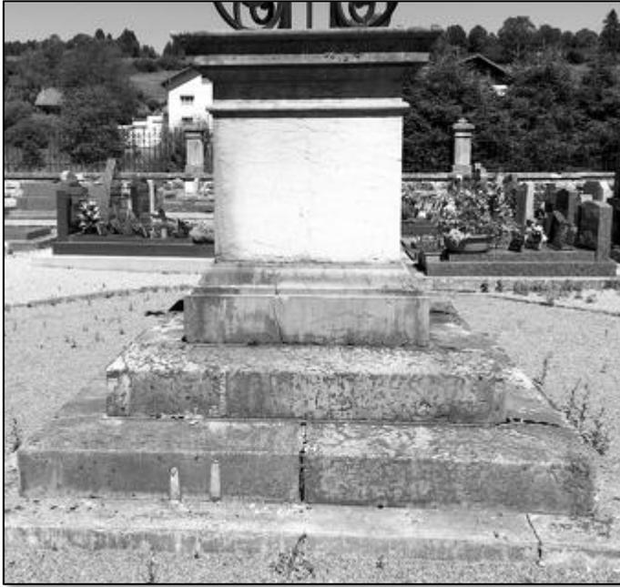
Le dé repose sur un base puissante comportant successivement une plinthe surmontée d'un talon. La corniche, au dessus du dé, est également bien moulurée, avec un cavet inversé, une petite plinthe se terminant par un nouveau cavet inversé, puis un tore terminal.
