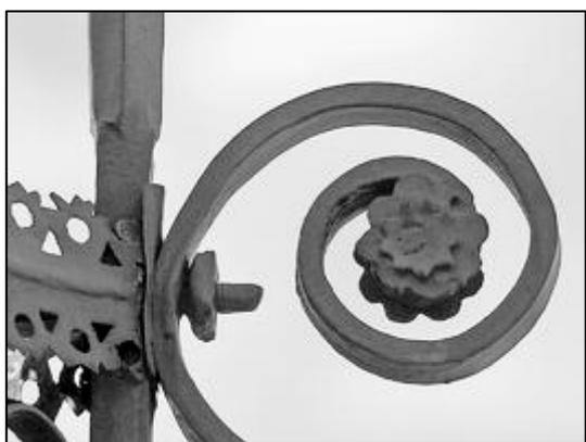
Après le lambrequin intermédiaire, les profils des fers des montants verticaux changent d'orientation (torsion à 45%) et s'alignent parallèlement aux faces du piédestal (voir sur la photo de gauche le détail du travail de forgeage des barres de fer).
