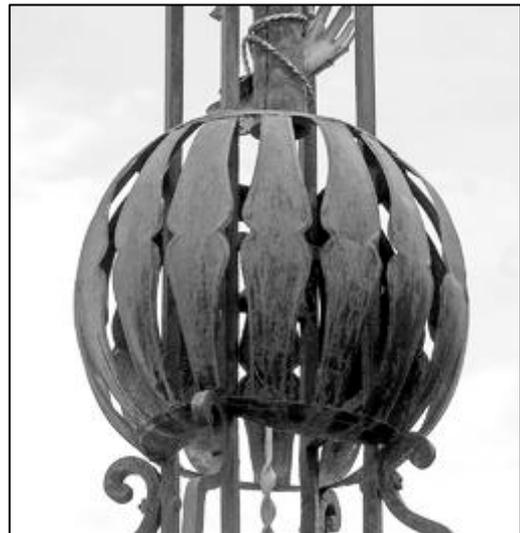
On peut en effet apercevoir à l'intérieur du globe, la présence d'un système complexe d'entretroisement avec croisillon. C'est de là que part vers le haut un fer de section carrée sur lequel sont fixés les instruments de la partie supérieure du fût.
