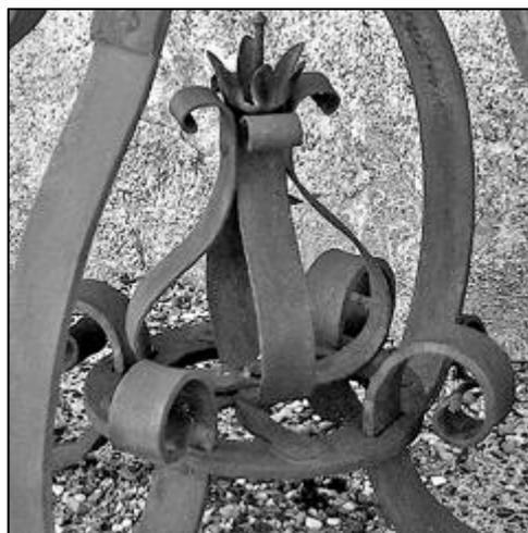
Les deux autres fers entament alors une ascension, devenant montants verticaux du fût de la croix. À l'intérieur du pied, entre les consoles, a été placé un dispositif complexe comportant une sorte de balustrade formé de quatre fers plats et fixé à la couronne de liaison des consoles. Le balustrade se termine par une fleur de lys avec pétales découpés et graine saillante .
