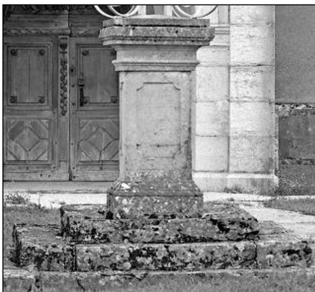
Le piédestal en calcaire repose sur une base ou emmarchement de larges dalles calcaires rectangulaires à trois niveaux.
