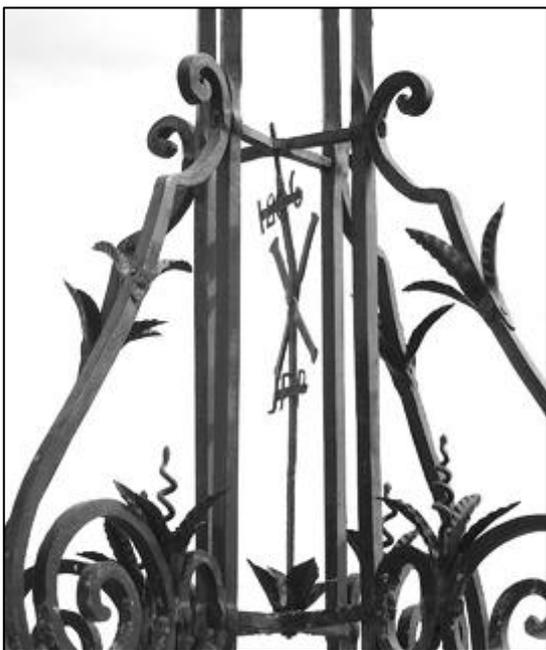
Au niveau des points d'attache des rouleaux haut et bas des consoles sur les fers des montants verticaux sont placés deux croisillons d'entretoisement. Une grande tige verticale relie les centres des deux croisillons. Elle permet de fixer plusieurs éléments d'un décor symbolique.
