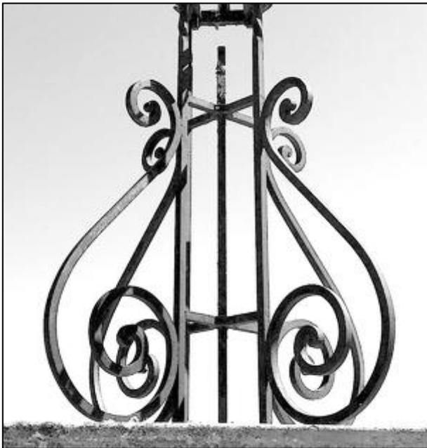
Quatre consoles, sans décor de tôle ajouté, sont orientées selon les diagonales du piédestal. Elles s'appuient sur les montants verticaux du fût. Les faces des fers de ces montants sont orientées comme les consoles, de façon à permettre une fixation facile.
