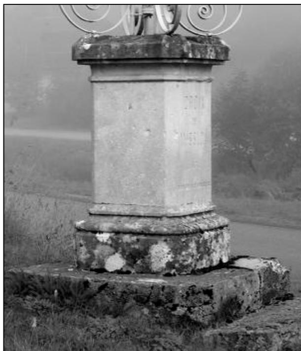
Le piédestal est constitué d'un dé vertical en pierre tendre de couleur ocre (grès, pierre de Molpré ou de Dommartin?). Il repose sur une dalle parallépipédique en calcaire dur.
