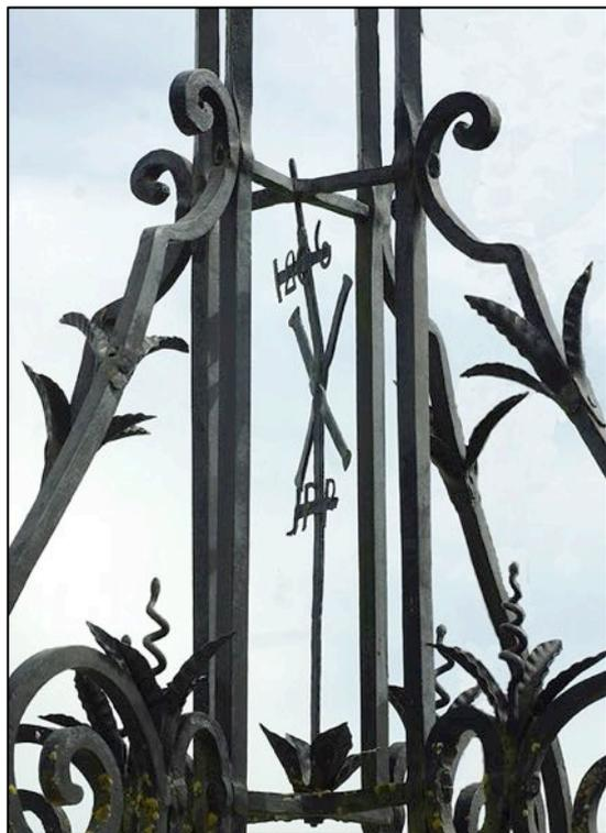
Au niveau des points d'attache des rouleaux hauts et bas des consoles sur les fers des montants verticaux, sont donc placés deux croisillons d'entretoisement en X. Une grande tige verticale relie les centres des deux croisillons. Elle permet de fixer plusieurs éléments d'un décor symbolique.
