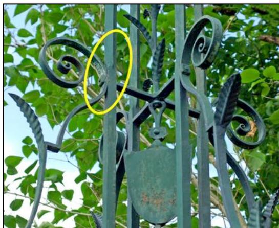
Des duos de feuilles d'eau nervurées, en fer étampé, sont soudés aux consoles au sortir des gros rouleaux. D'autres feuilles isolées sont placées au niveau des redans, dirigées vers l'extérieur et vers le haut.
