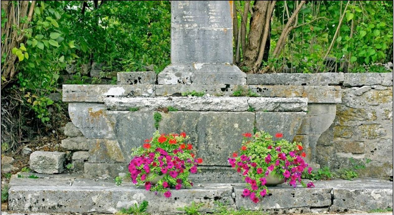
La partie avant de la table-autel en tronc de pyramide inversé est réalisée avec de grands blocs de pierre inclinés vers le bas. La dalle supérieure très dégradée a été remplacée en 2019 par un dalle bétonnée.
