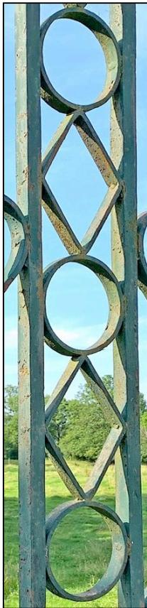
Le pied de la croix et les branches libres reçoivent un décor de remplissage purement abstrait, géométrique, constitué d'alternances de losanges et de cercles en fer plat, motifs élémentaires soudés entre eux et fixés aussi par rivetage ou vissage aux montants structurels de la croix.
