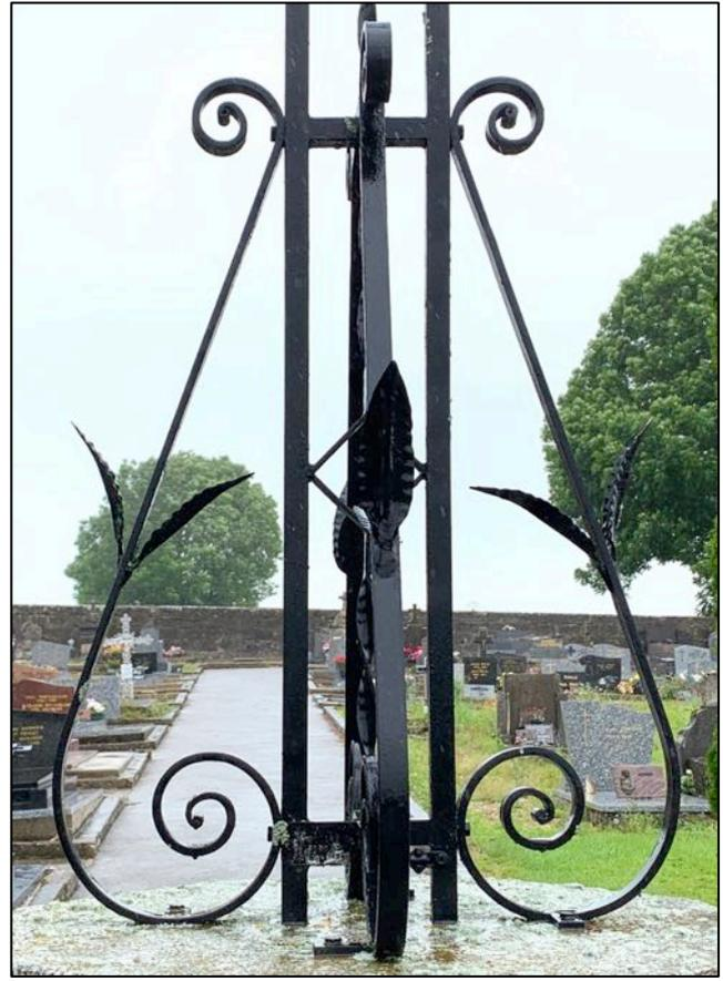
Les consoles en fer plat sont en forme de S avec un gros rouleau en partie basse et un plus petit rouleau (ou volute) en partie haute). Les rouleaux sont liés entre eux par un long fer en ligne droite. À mi-hauteur de chaque console, a été disposé un duo de feuilles d'eau en fer étampé.
