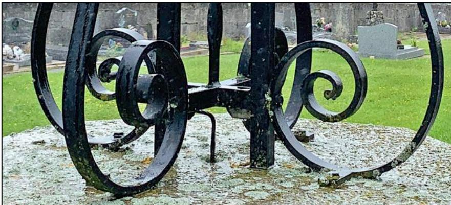
En partie basse, les fers des rouleaux sont fixés par boulonnage aux extrémités d'une entretoise en croix, soit directement, soit indirectement avec interposition des fers structurels montants. Un dispositif identique permet la fixation des petits rouleaux supérieurs.
