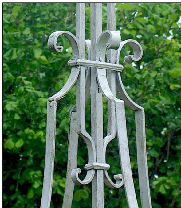
On peut noter, au passage, le dispositif d'attache des fers extérieurs du pied du croisillon sur le montant central, avec là-encore un collier à baguette (solution technique caractéristique des croix en fer forgé du XVIII<sup>e</sup> siècle). Ces fers extérieurs se terminent, vers le bas, par de petites volutes, avec un amincissement réalisé par forgeage de leur section (passage d'un fer carré à un fer plat).
