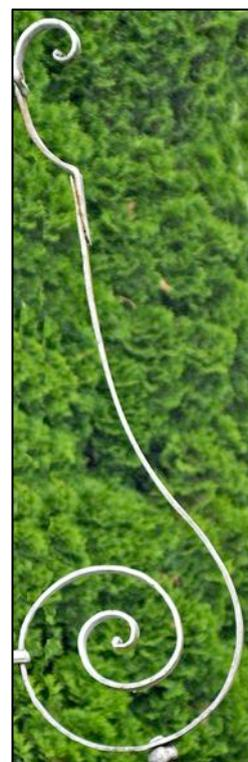
Les volutes supérieures viennent se fixer soit sur le fer montant central, soit sur les fers extérieurs du pied du croisillon. Un large collier rectangulaire et à baguette vient enserrer tous ces fers (dispositif d'attache différent de celui de Bief-du-Fourg). Une petite clavette a été ajoutée pour consolider l'assemblage.
