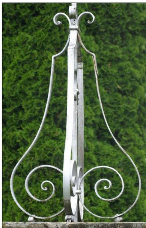
Les consoles, réalisées en fer plat, sont en forme de S avec de gros enroulements à la base et de plus petits (simples volutes) en hauteur.
