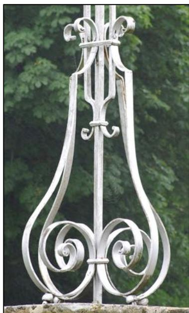
Au-dessus du piédestal, un dispositif de soutien formé d'un ensemble de quatre consoles vient maintenir et stabiliser la grande barre verticale montante réalisée en fer de section carrée de grosse largeur.
