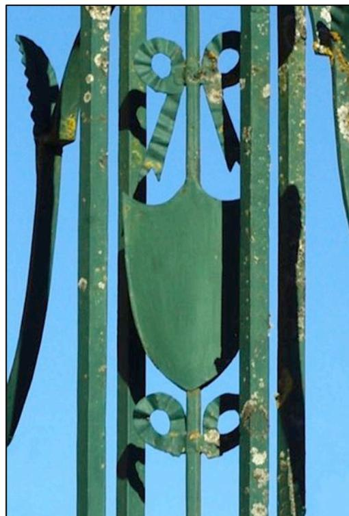
Réalisé en fer forgé et étampé, ce décor plan (donc non visible quand on tourne de 90° autour de la croix) est fixé sur une tige verticale. Celle-ci est reliée aux deux croisillons haut et bas du fût, avec, pour l'attache supérieure, recours à une sorte de ganse.
