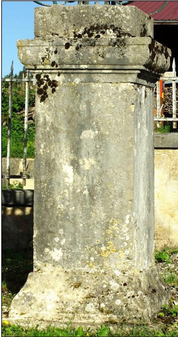
Le pied du piédestal repose sur une dalle carrée ancrée dans le sol (pas d'emmarchement) et comporte une belle mouluration avec une petite plinthe surmontée d'un talon renversé.
