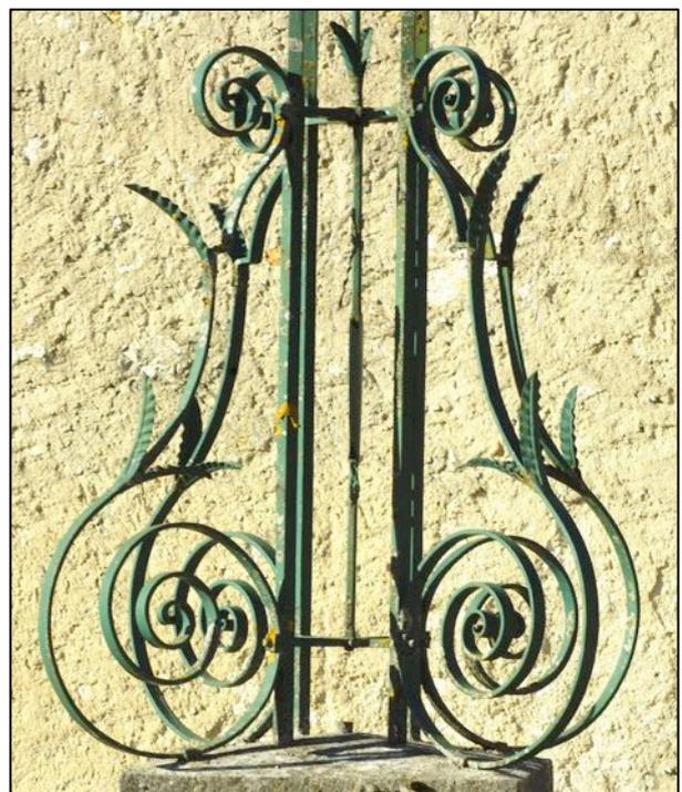
La partie basse du fût comporte quatre élégantes consoles, positionnées selon les diagonales du piédestal de façon à renforcer la stabilité de la croix et aussi de contribuer à une esthétique générale aérée. On retrouve ce type de consoles à Dommartin, Bonnevaux, Malpas, etc..
