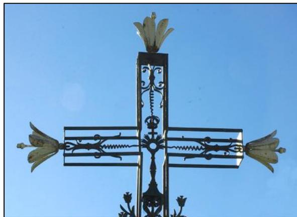
Ces branches libres se terminent par des platines ou plaques en tôle de fer auxquelles sont fixés, d'une part, les décors intérieurs (fleurons en fer forgé à graine vrillée) et, d'autre part, extérieurs (grandes fleurs de lis à graine émergente en fer étampé).
