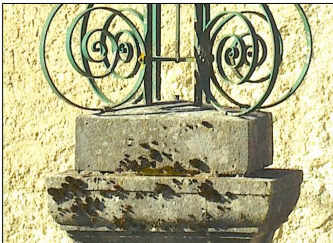
Un dé ou tailloir supplémentaire, important et à face supérieure bombée, est posé sur la corniche. Il permet l'ancrage des fers montants de la croix ainsi que de ceux des consoles.
