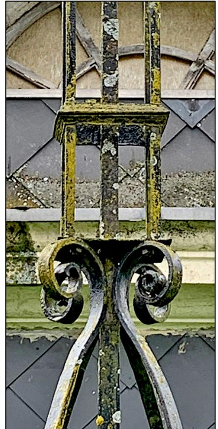
S'il présente une structure classique composée de quatre fers de section carrée délimitant le contour ou volume virtuel du pied, celui-ci voit passer en son centre le gros fer structurel venant de la base de la croix. À noter la différence de taille des 4+1 fers verticaux.
