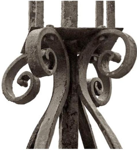
À noter que les rouleaux bas sont ancrés (par boulonnage) sur la corniche sans toucher le fer structurel central.
