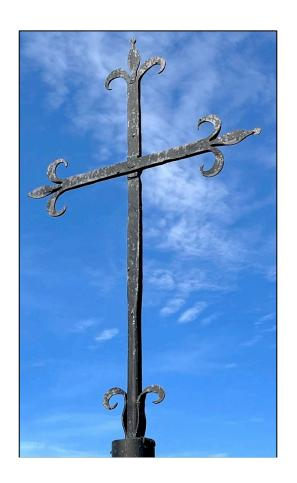
Le croisillon de la croix du Cernois est basé sur une structure unidimensionnelle (1D) constituée d'un puissant fer montant allant en s'aplatissant vers le haut. Ce montant vient croiser une traverse en fer de section rectangulaire (fer aplati à la forge).
