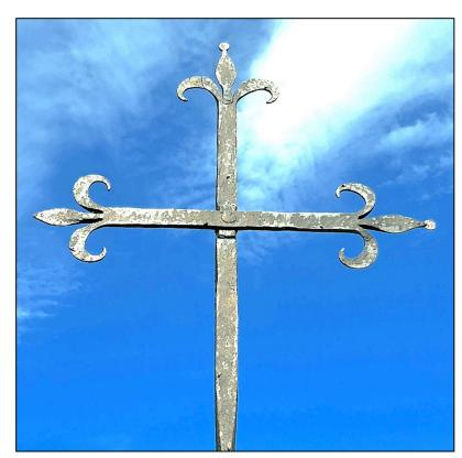
La partie haute du croisillon est des plus intéressantes. Le montant vertical poursuit son ascension au delà de la croisée des branches. Vient se fixer sur lui la traverse horizontale, l'assemblage des deux fers étant réalisé par un fort rivet, avec surépaisseur aménagée.
