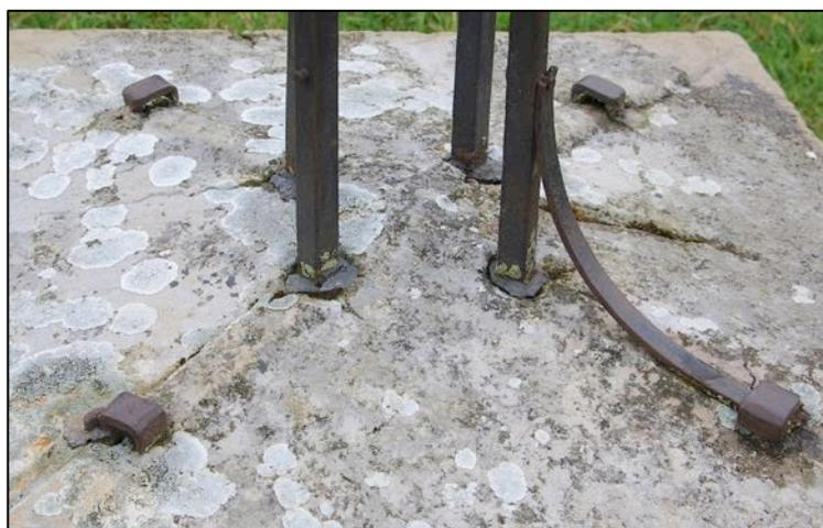
La croix devait comporter quatre consoles en fer plat venant s'appuyer sur les fers carrés des montants du fût de la croix. Des attaches-crampons en fer sont encore en place dans la pierre du socle. Subsiste également un fragment de rouleau d'une console.
