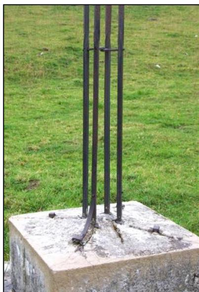
Mais alors que les consoles doivent venir s'appuyer sur les fers montants du fût (selon les axes diagonaux du socle) et qu'en partie haute, le croisillon doit présenter des fers avec des faces parallèles aux axes transversaux du socle, il faut réaliser une torsion à 45° des fers à une certaine hauteur du fût.
