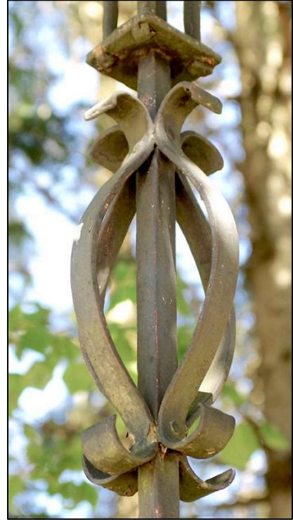
Le travail de ferronnerie est dans la continuité de celui fait au niveau des quatre consoles. On retrouve le même style de mise en courbure des fers plats et le même aplatissement des fers aux extrémités des volutes. Par contre, les assemblages des arceaux sur la barre structurale montante sont réalisés par rivetage et non par des boulons. Outre sa fonction esthétique, le globe à arceaux est aussi porteur de la symbolique du "Divin".
