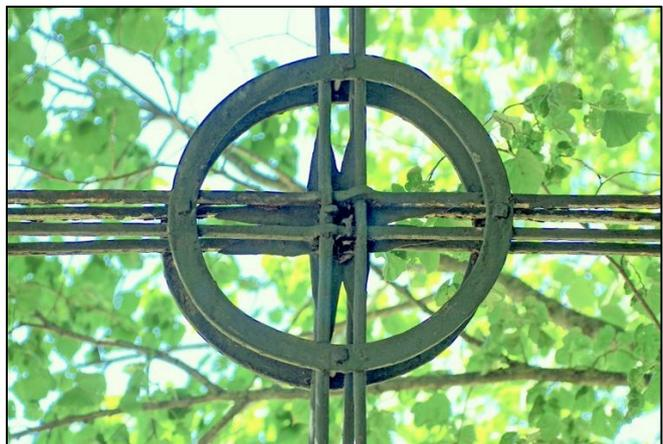
L'assemblage de ces quatre fers, au niveau de la croisée centrale, est assuré par un dispositif à trous et renflements, avec alternance des passages (intérieur ou extérieur). Ce mode d'assemblage est typique des pratiques de ferronnerie anciennes : on le retrouve aux croix de Gellin (Doubs) ou de Montigny-les-Arsures (Jura).
