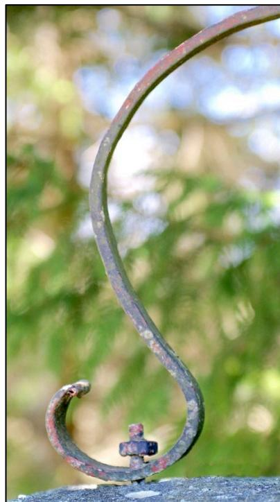
En partie haute, les fers plats viennent tangenter la barre structurale montante. La fixation est assurée par boulonnage mais de façon nettement plus discrète et esthétique qu'au bas des consoles. Il convient de souligner le beau travail de ferronnerie ainsi réalisé, avec un dessin ("design") des consoles caractéristique des XVII<sup>e</sup> et XVIII<sup>e</sup> siècles.
