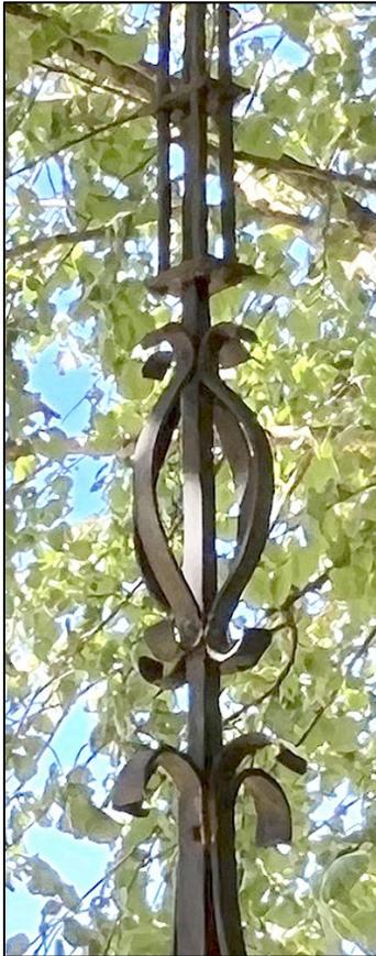
Un globe ovoïdal, constitué de quatre arceaux en fer plat en forme de C avec volutes terminales, vient donc entourer la tige montante, formant une sorte de manchon virtuel.
