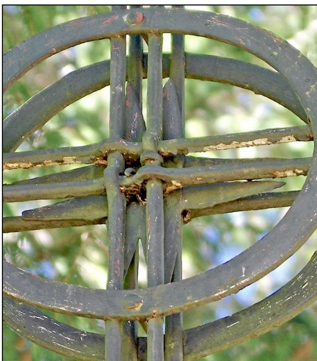
Le second décor, encore plus étonnant, se situe à l'intérieur même de la structure du croisillon. Il s'agit d'une étrange étoile à huit branches en fer plat, ou plutôt une étoile à quatre branches dont chacune comporte deux rayons parallèles. Cette étoile qu'il a fallu insérer dans la structure au moment de l'assemblage des fers structurels semble être maintenue sur la structure par des crochets à ces fers.
