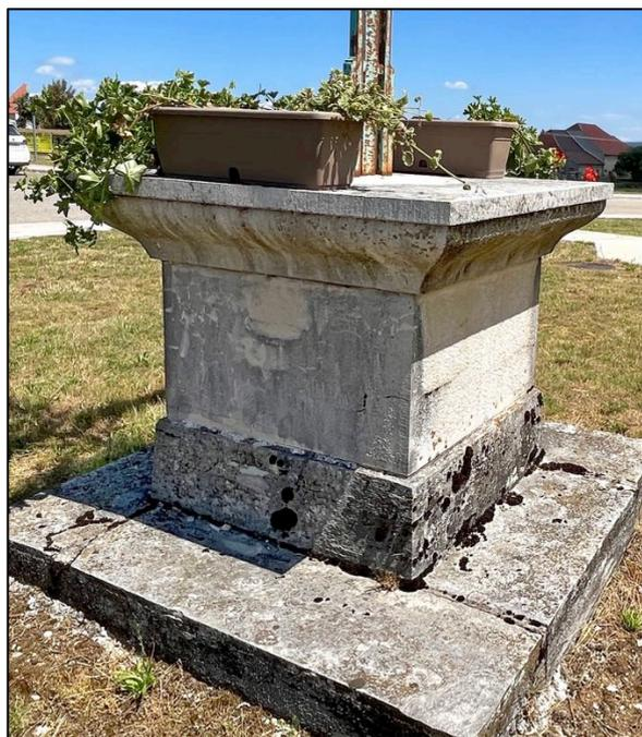
Ce piédestal de forme parallélépipédique repose sur un dallage formant simple emmarchement. Il comporte successivement une base à haute plinthe, un dé ou corps principal et enfin une pierre de corniche moulurée (avec talon surmonté d'un réglet).
