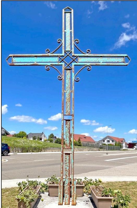
Les fers de structure sont régulièrement reliés entre eux par des entretoises orthogonales en fer plat. Ces entretoises permettent, par ailleurs, la fixation des bandes décoratives en tôle de fer striée.
