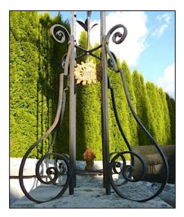
La partie basse du fût est solidement maintenue grâce à de grandes consoles qui s'appuient sur le haut de la corniche en pierre ainsi que sur les fers montants du fût. Les consoles, en fer de section carrée, sont en forme de S avec enroulements inversés; elles présentent un redan horizontal juste avant le départ des rouleaux supérieurs.
