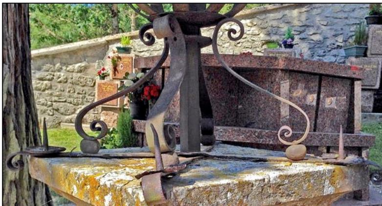
Les quatre consoles en fer plat, en forme de S et avec rouleaux terminaux, assurent la stabilité de la partie ferronnée de la croix. Elles sont positionnées sur les diagonales de la corniche de façon à obtenir la meilleure assise possible pour lutter contre le renversement.
