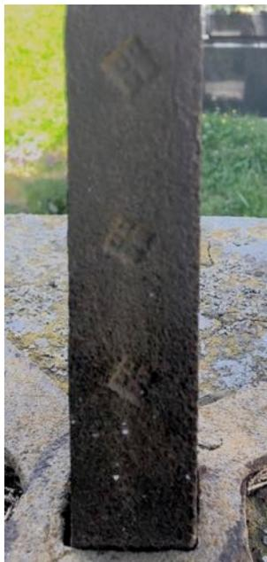
Un examen attentif du fer structurel vertical révèle la présence de marques imprimées à chaud dans le métal. Ces marques, en nombre variable (3 sur une face, 1 sur une autre), se présentent sous la forme de losanges composés eux-mêmes de 4 petits losanges, avec une petite surélévation (globule) au centre de chaque petit losange ; on peut aussi y voir une forme en croix.
