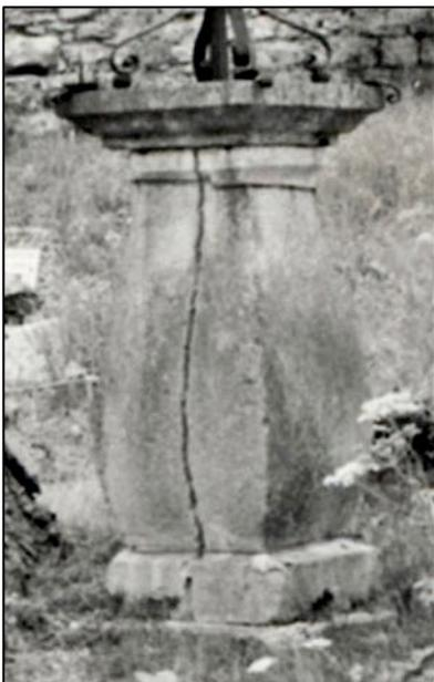
Le piédestal est malheureusement en assez mauvais état. Un cliché de 1984 révèle une profonde fissure verticale. Celle-ci ne semble pas avoir encore atteint la face opposée. Elle a été colmatée lors de l'opération récente de remise en état du site et d'abattage du résineux. Un ceinturage déjà visible en 1984 a été réalisé avec un fer très discret ?
