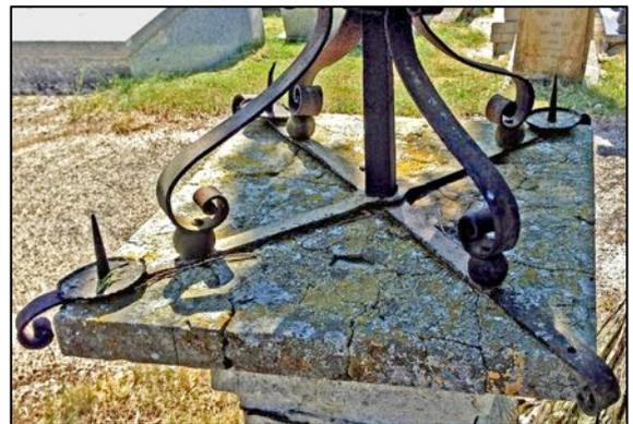
Une réservation dans les fers plats permet le passage du gros fer montant de section carrée, au centre du dispositif ; ce fer structurel carré est scellé dans le bloc de pierre.
