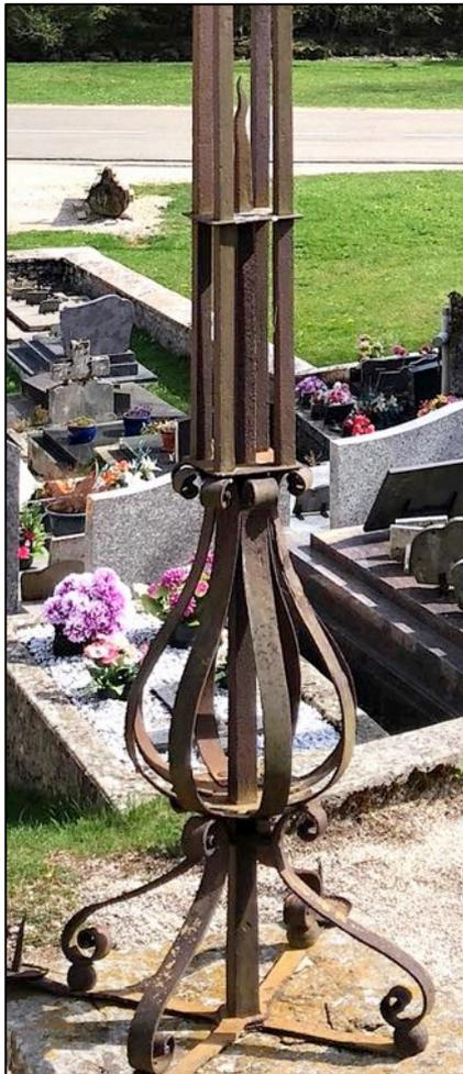
En partie basse du pied du croisillon, le fer carré vertical central passe à travers une platine horizontale d'entretoisement. Il se poursuit, plus haut sous forme d'une lance à flamme ondulante, sorte de rayon de gloire (flamme ou lance selon le profil choisi).
