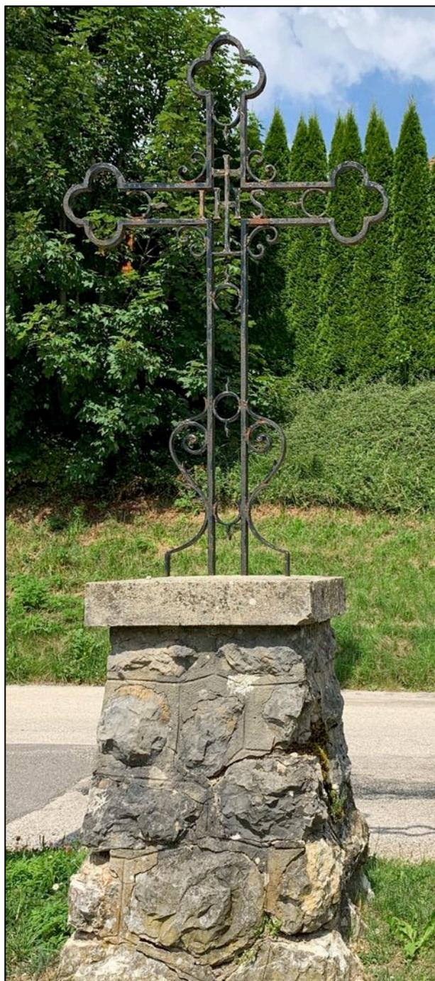
La croix s'élève sur un piédestal en forme de tronc de pyramide de section carrée, réalisé en blocs de pierres cimentés et jointoyés.
