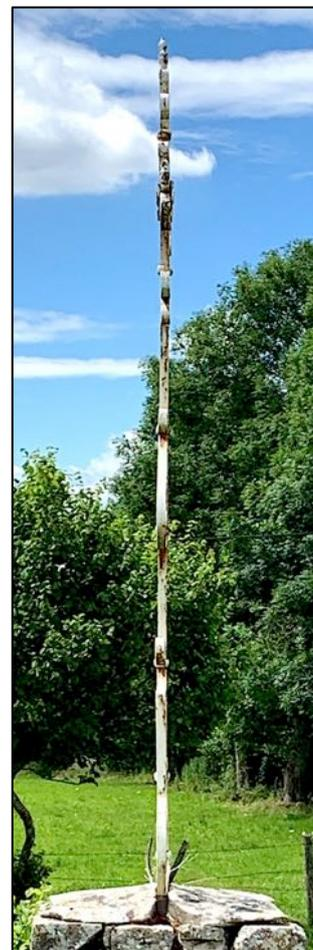
Une tige verticale en fer de section carrée plutôt large constitue l'armature principale de la croix (1D) ; viendront s'y souder les fers carrés identiques de la traverse.
