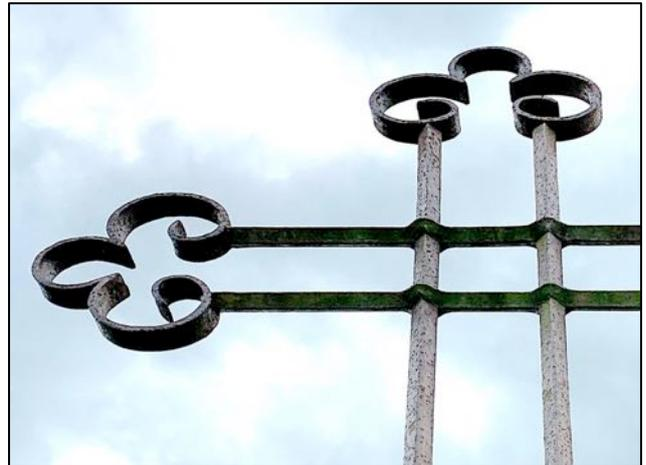
À noter encore la réalisation différente des montants (fers carrés sur angle) et des trèfles d'extrémité (fers plats).
