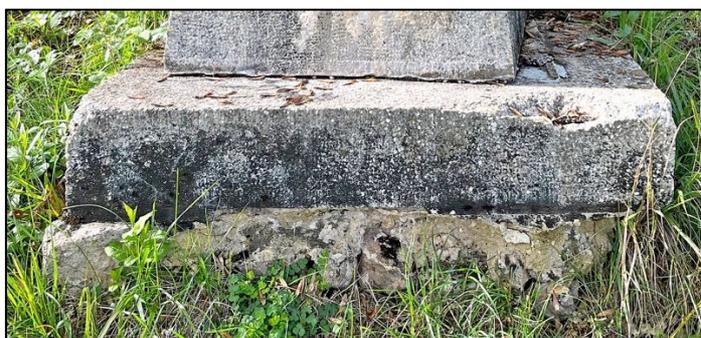
La base et le dé tronconique du piédestal semblent être en béton d'agrégats avec un léger bouchardage en surface. Étrangement, la base n'est pas dans l'axe vertical du dé, ce qui conduirait à retenir une possible modification ou reconstruction du piédestal.
