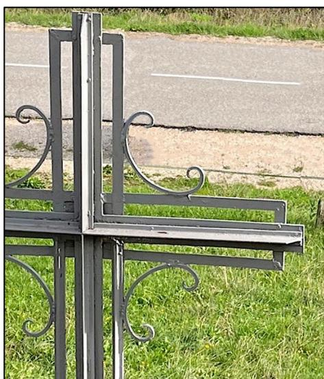
À l'arrière du fer plat central du pied et des branches libres de la croix est fixé, par vissage, un puissant fer en T (de type cornière). C'est donc une structure complexe de type linéaire 1D (unidimensionnelle).
