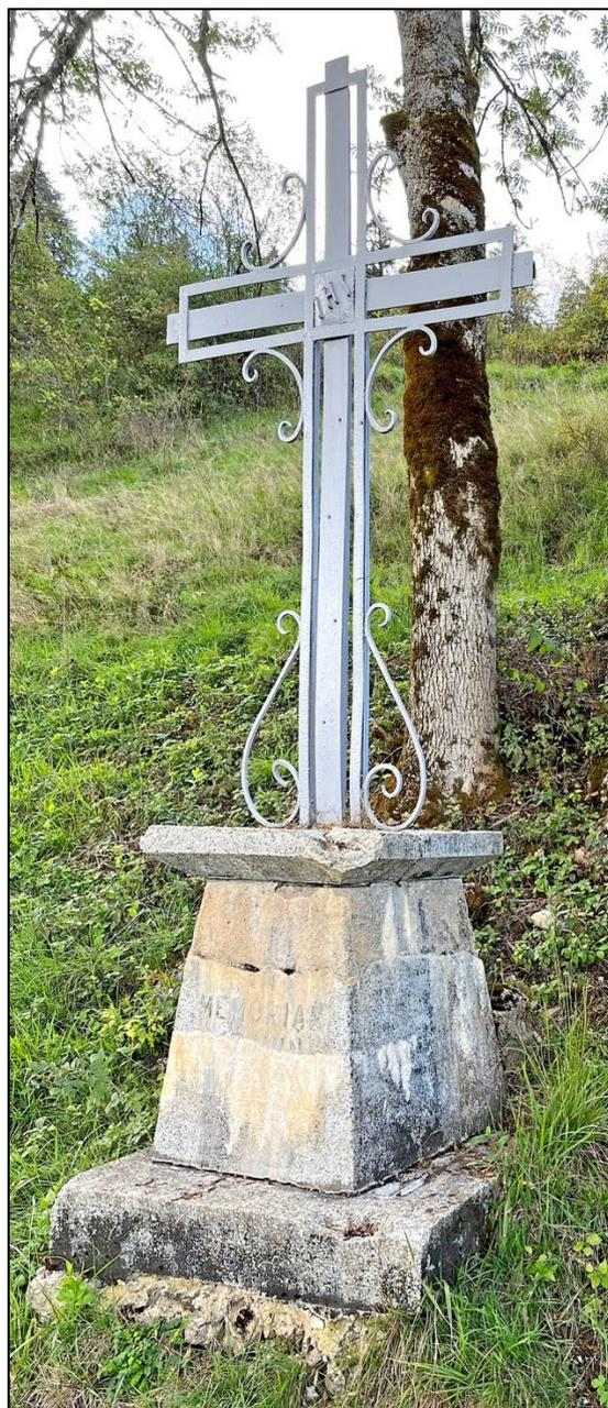
La croix en fer forgé, d'un style caractéristique des années 1940-1950, comporte une structure complexe unidimensionnelle (1D), en partie cachée par le décor en face avant de la croix. Cela nous conduit à la définir comme de type FF1D (avec 2 consoles latérales), même si une partie du décor en fer plat contribue aussi à la résistance mécanique de la croix.
