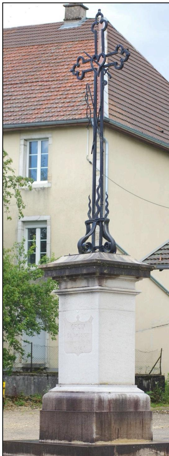
La croix en fer forgé tardive (1864) de la rue Monclar à Laviron est de type à structure bidimensionnelle (2D), renforcée en pied par quatre petites consoles en fer plat, placées sur les axes principaux de la croix.
