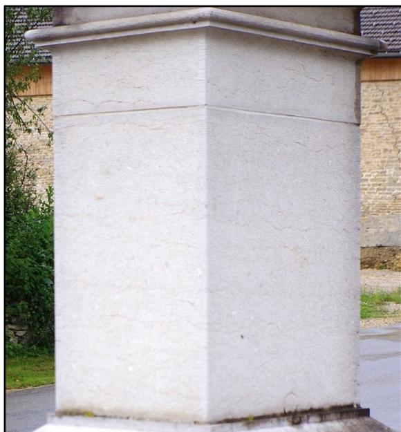
Le dé (corps principal), parallélépipédique, est constitué de deux blocs superposés, de taille inégale. Le bloc supérieur se termine par une moulure torique (en lien avec la corniche). Les quatre faces du dé sont bouchardées.
