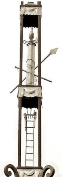
Les deux modules au-dessus des consoles (modules intermédiaire et supérieur) présentent la même structure, avec des fers progressant vers le haut de la croix, avec leurs faces désormais parallèles aux axes principaux de la croix et du piédestal.
