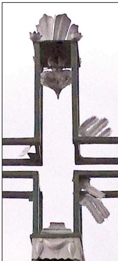
À l'intérieur du montant vertical, au-dessus du lambrequin, existe encore un petit socle en tronc de pyramide à profil curviligne. Il devait vraisemblablement supporter, à l'origine, un décor de type ostensor (en lien avec le miracle de Favorney de 1608).
