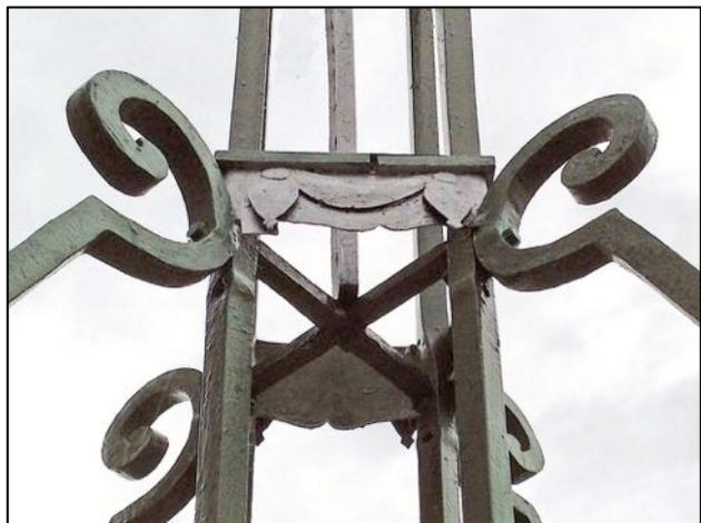
Dans le haut de ce premier module inférieur, les volutes viennent se fixer par boulonnage aux montants verticaux du fût et aux extrémités d'un croisillon d'entretoisement. À noter que les gros rouleaux du bas du module ne sont pas liés aux montants verticaux du fût mais seulement ancrés sur la corniche du piédestal.
