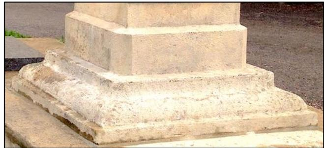
La corniche du piédestal est réalisée en béton cellulaire moulé, avec granulats apparents. Elle voit se succéder, de bas en haut, trois plinthes de hauteurs de plus en plus restreintes au fur et à mesure que la corniche s'élargit. Leur succède un quart de rond surmonté d'un réglet.
