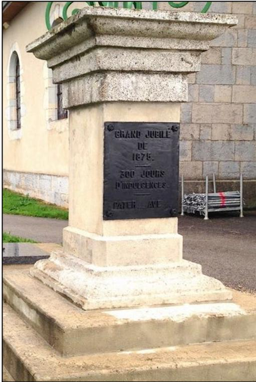
Le piédestal, repose sur un emmarchement moderne de plan carré et composé de trois niveaux ou marches avec revêtement extérieur cimenté (marches en béton ?).
