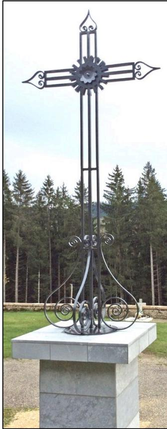
Une première et importante opération, immédiatement visible, a trait au piédestal très dégradé remplacé par un socle moderne en béton recouvert de plaques de pierre. La forme et l'allure du piédestal ont radicalement changé, avec désormais une esthétique très sobre, quelque peu maladrite
