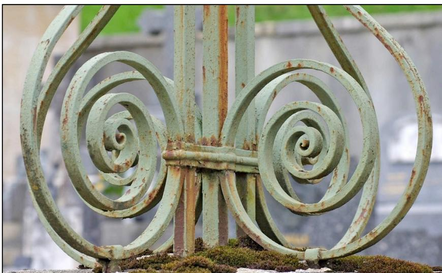
Les rouleaux bas sont ancrés dans la pierre de la corniche et sont fixés par ailleurs aux fers structurels montants par l'intermédiaire d'un large collier à baguette. Deux consoles sont attachées aux fers extérieurs du fût, les deux autres au fer central.
