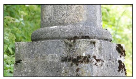
En partie haute, une autre petite moulure torique en relief a été créée de façon à maintenir en place le dispositif en fer forgé de maintien du croisillon sommital en fer forgé sur le fût.
