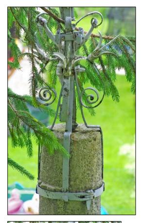
Le pied du croisillon est un dispositif complexe, composé de quatre consoles stabilisatrices qui viennent se fixer, en partie basse sur le sommet de la colonne-fût et s'appuyer en partie haute, sur un fer carré central montant se continuant dans les branches du croisillon.
