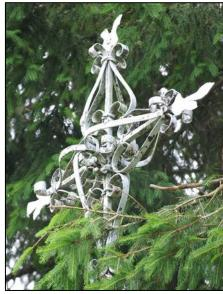
On retrouve, au centre des branches (ou des balustres) le gros fer carré structurel (1D) du pied du croisillon qui monte jusqu'au sommet de la croix. Les fers carrés de la traverse horizontale, de même section, viennent s'appuyer sur ce fer vertical.
