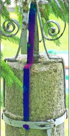
En complément, des consoles en S, viennent renforcer la structure. Elles comportent des rouleaux à chaque extrémité. En bas, les rouleaux s'appuient sur le fer oblique précédemment décrit.
