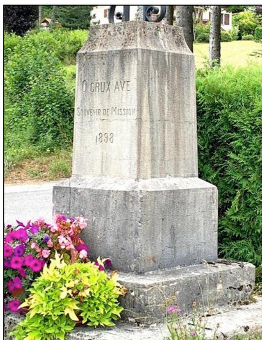
Le piédestal, plutôt élancé, combine un ensemble de blocs de pierre superposés, dont une base à 2 niveaux parallélépipédiques. Le dé principal est en forme de tronc de pyramide de section carrée se terminant, en haut, par un creusement en cavet renversé.
