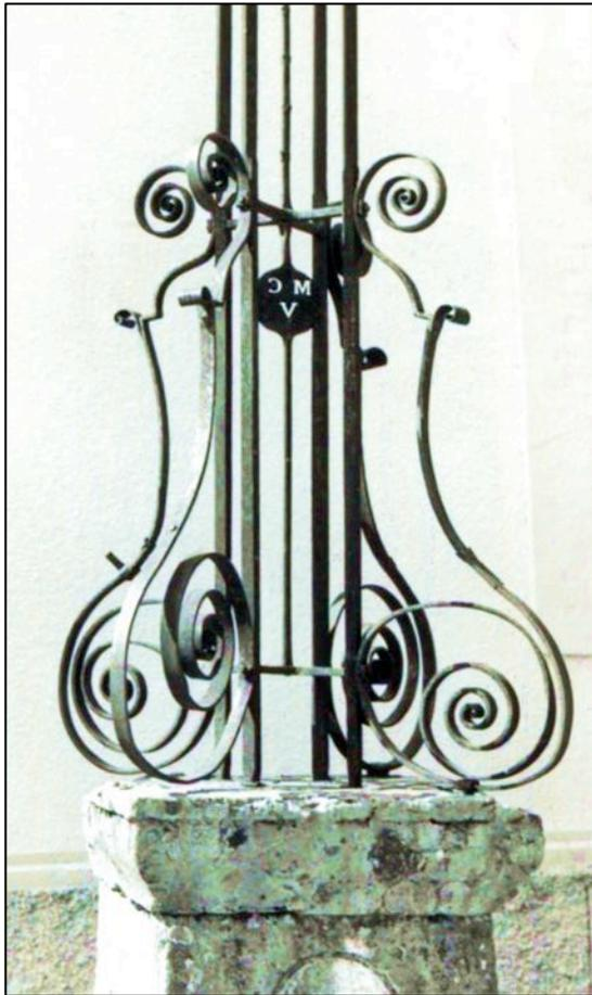
Les montants verticaux sont réalisés en fer de section carrée. Les profils des fers sont d'abord orientés, en partie basse du fût, selon les diagonales du chapiteau du piédestal.
