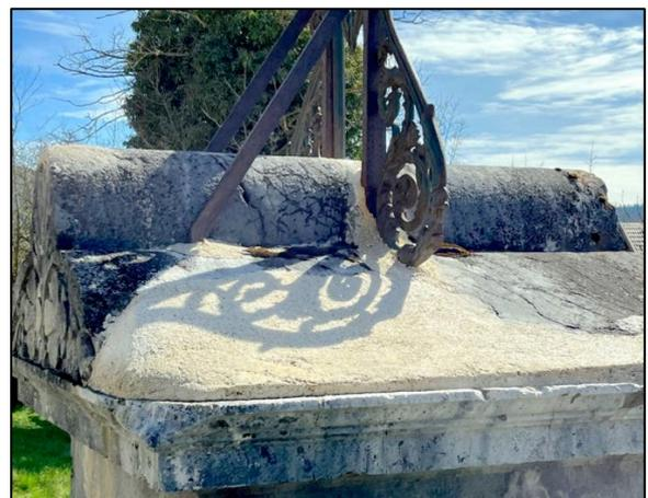
Il a fallu réaliser un sérieux travail d'ajustement pour venir "planter" correctement le pied de la croix en fonte sur le "toit" de l'édicule. Les deux montants en fer forgé du pied de la croix ont été encastrés dans la pierre, de part et d'autre de la ligne faîtière de la "toiture".
