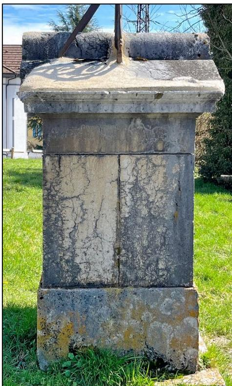
D'un point de vue constructif, l'édicule, posé sur une dalle de sol, comporte, en partie basse, un bloc calcaire monolithique de section carrée et d'une vingtaine de cm de hauteur, formant une sorte de plinthe avec un léger débord par rapport aux parties supérieures.
