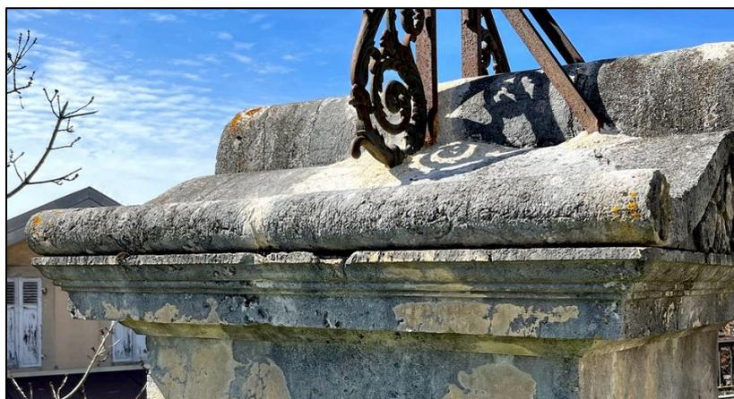
Sur l'axe central de la "toiture", la forme se redresse brusquement pour dégager, en élévation, un demi-cylindre de section ovale pointant vers le ciel et formant nervure centrale ou ligne faîtière de la "toiture".
