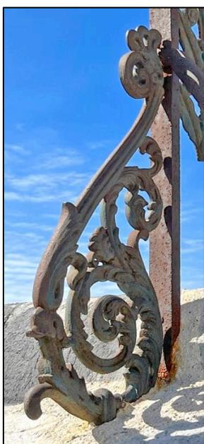
Deux fausses-consoles - ou "ailerons latéraux" - sont disposées de chaque côté des fers structurels ou montants verticaux du pied de la croix. Ces ailerons en fonte moulée de production industrielle ne contribuent aucunement à la résistance de la croix aux effets mécaniques transversaux (contrairement aux "vraies" consoles diagonales des croix intégralement en fer forgé). Ils sont purement décoratifs (dans le style de l'époque).
