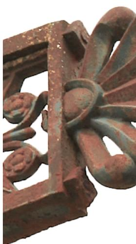
Ajoutons que de discrets et fins rivets sont ajoutés tout au long des fers structurels pour fixer et assurer l'assemblage des décors en fonte moulée sur les montants de la croix.
