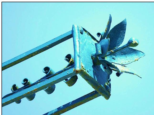
Des platines en tôle de fer assurent la clôture des branches libres vers l'extérieur (avec rivetage des extrémités des montants structurels). Elles comportent un rebord torique (disposition assez rarement utilisée dans les croix FF3D du Haut-Doubs).
