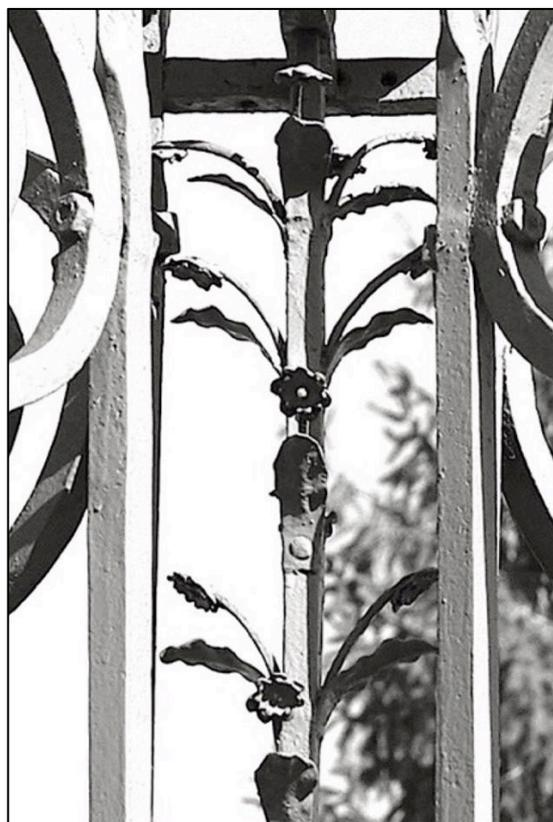
À noter, après l'attache haute des rouleaux des consoles, la torsion des fers montants du fût (torsion de 45°). Elle permet de remettre les faces des fers montants parallèles aux axes principaux de la croix alors que, plus bas, elles s'orientent selon les diagonales du piédestal. Là-encore un classique de la réalisation des croix FF3D du Haut-Doubs.
