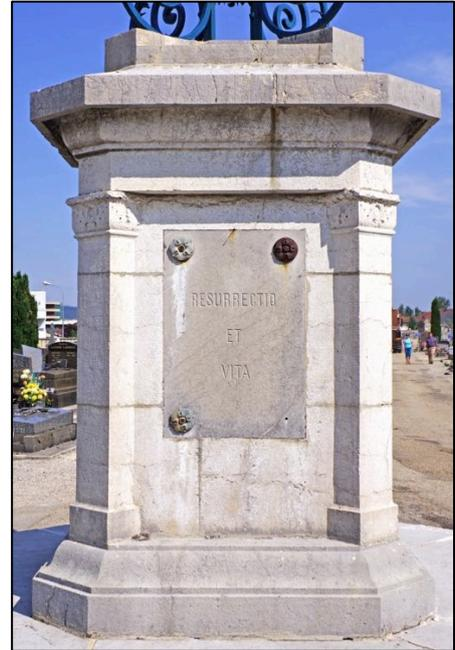
La base octogonale comporte une plinthe surmontée d'une doucine inversée. La corniche débordante comporte plusieurs étages dont l'un avec moulure en quart-de-rond. Le dé (corps principal) de section carrée est flanqué de pilastres à chapiteaux finement sculptés.
