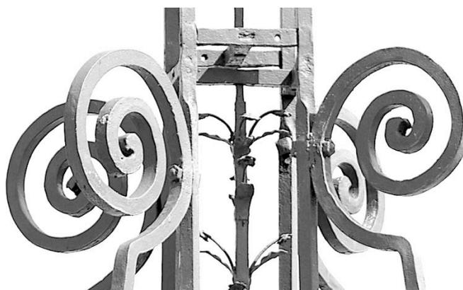
La partie basse du fût se termine par un nouveau dispositif d'entretoisement (mais non plus en forme de croisillon) : les assemblages des fers sont réalisés par tenons et mortaises. On peut observer la présence de trous dans les fers, pouvant laisser penser à de possibles fixations de décors ayant disparu.
