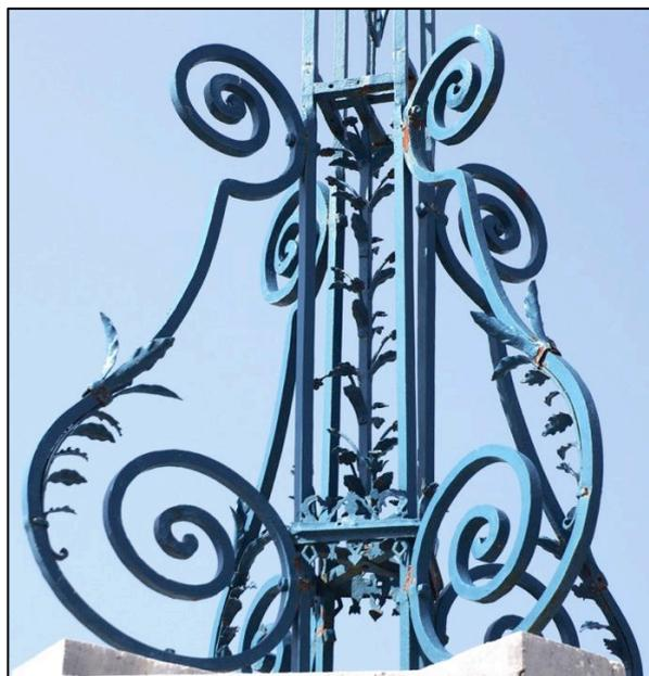
Les enroulements inversés, en bas et en haut, sont de tailles différentes. Les consoles présentent une brisure de tracé juste au départ des rouleaux supérieurs, conférant une certaine élégance à ces soutiens.
