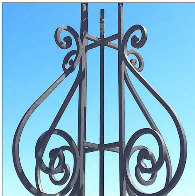
Ces fers verticaux subissent une torsion à  $135^\circ$  ( $45+90$ ), bien visible, au-dessus des consoles, de façon à ce que leurs faces se remettent parallèles aux faces du piédestal juste avant le dé-lambrequin.
