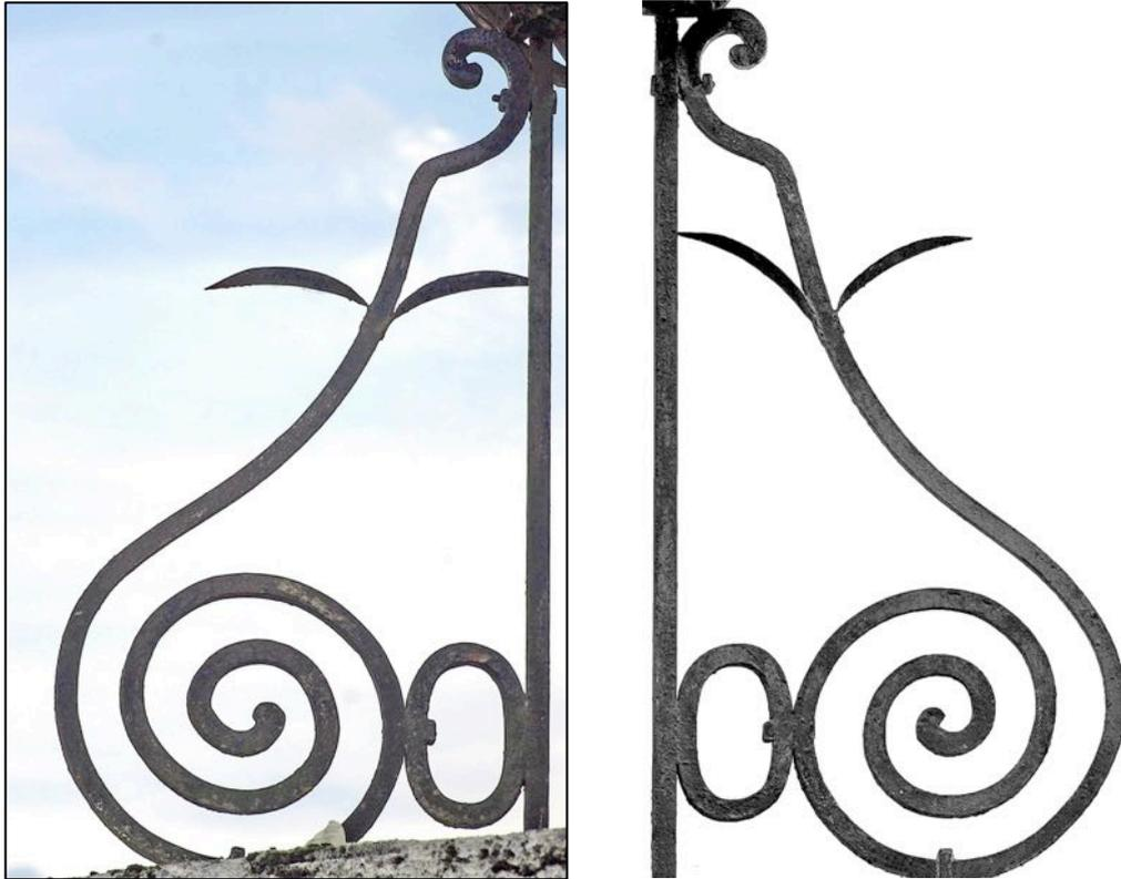
Les montants du fût sont, eux aussi, réalisés en fer de section carrée. L'orientation des faces de ces fers se fait selon les axes diagonaux de la corniche, ce qui permet la liaison aisée entre fers des consoles et montants du fût. Comme on verra plus loin, à l'intérieur du globe, les montants du fût devront changer d'orientation et subir une torsion de 45°.
