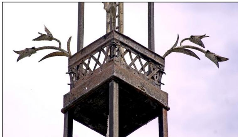
Un dé parallélépipédique avec plate-forme en tôle assure l'encastrement des montants verticaux du fût.
