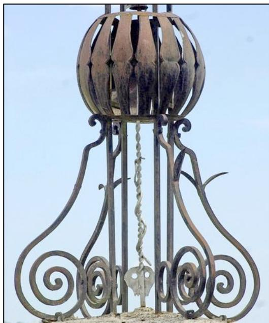
Quatre consoles en fer forgé sont positionnées sur les diagonales de la corniche de façon à accroître la stabilité de la structure. Des crochets permettent de fixer et sceller les consoles sur la dalle de la corniche.
