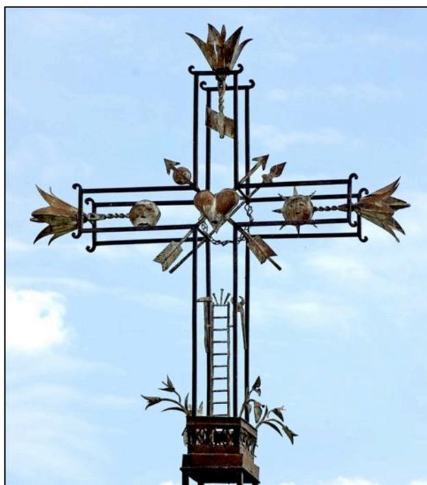
Le croisillon est une structure autonome, indépendante du fût sur lequel il vient se poser. Sa réalisation diffère de celle du fût, avec des fers de section plus petite. Le principe conceptuel reste le même, à savoir pouvoir créer de "pseudo-volumes" délimités par les fers ou montants dans lesquels seront disposés des décors variés.
