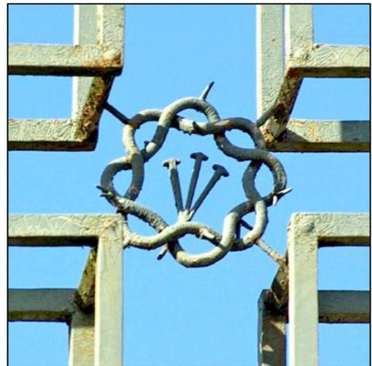
En observant le dispositif structurel au téléobjectif, on peut voir que les entretoises horizontales ont été positionnées avec une rotation de 45° de leurs fers, ce qui a rendu possible une réalisation plus simple des attaches de la couronne d'épines à ces entretoises.
