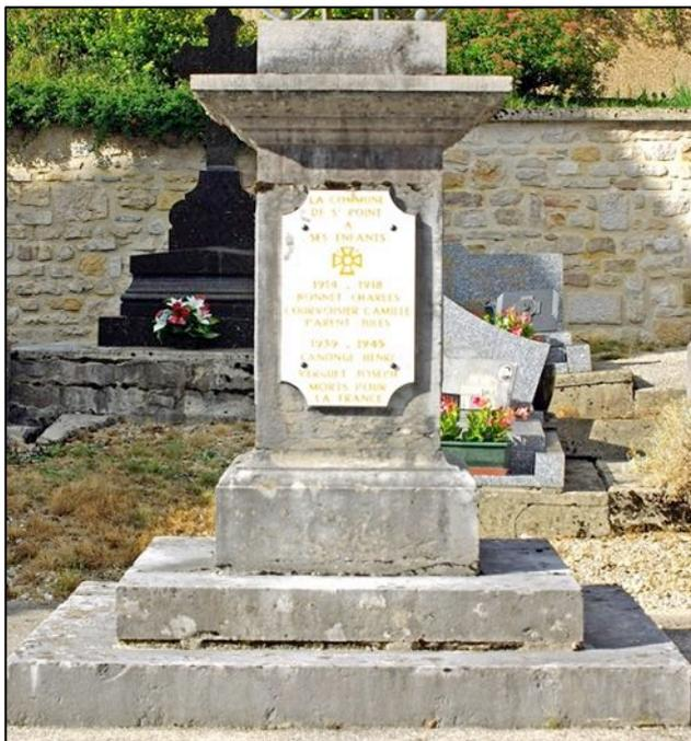
Le piédestal en calcaire repose sur un emmarchement de section carrée et à deux ou trois degrés (un 3<sup>ème</sup> visible en 1984 ne l'est plus depuis cette date).
