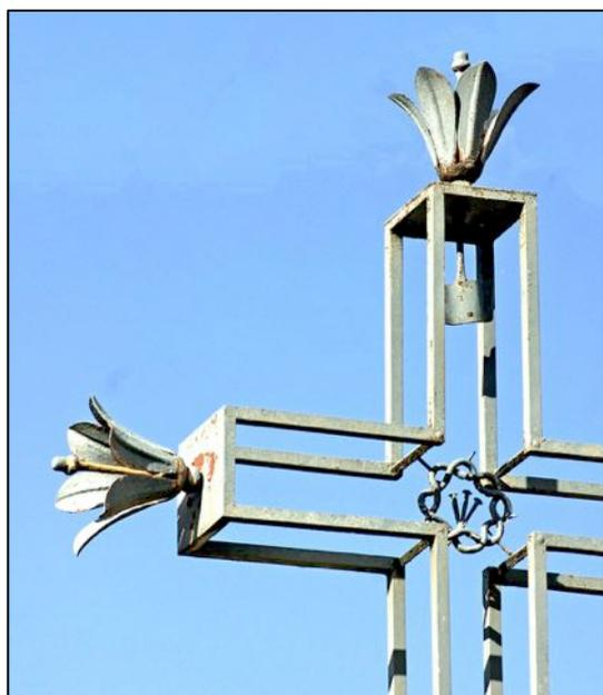
Des perles en fer étampé font la liaison entre les fleurs et leur fixation sur les platines en tôle des extrémités.
