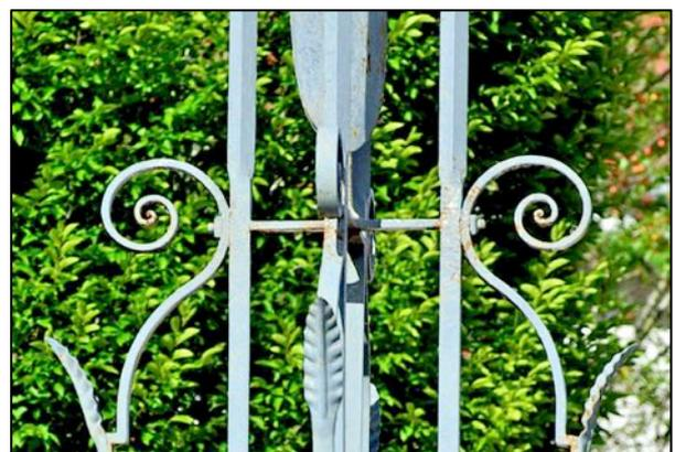
De section carrée, les fers verticaux changent l'orientation de leurs faces après ce point d'attache. Il subissent alors une torsion de 45°. Les faces des fers orientées selon les diagonales du piédestal se retrouvent ainsi parallèles aux axes principaux du piédestal et de la croix.
