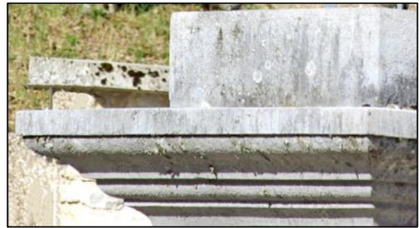
La corniche est surmontée d'un dé en pierre ou fort tailloir formant surélévation et sur lequel vient se fixer la croix par l'intermédiaire de perles métalliques.
