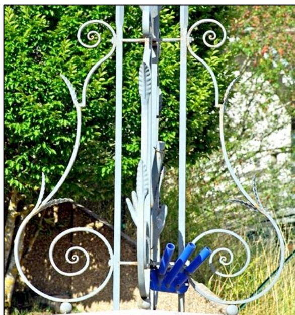
Les consoles comportent des duos de feuilles d'eau en tôle étampée au sortir des gros rouleaux du bas ainsi qu'une troisième feuille isolée en extension vers l'extérieur au niveau du redan entre rouleaux bas et rouleaux hauts
