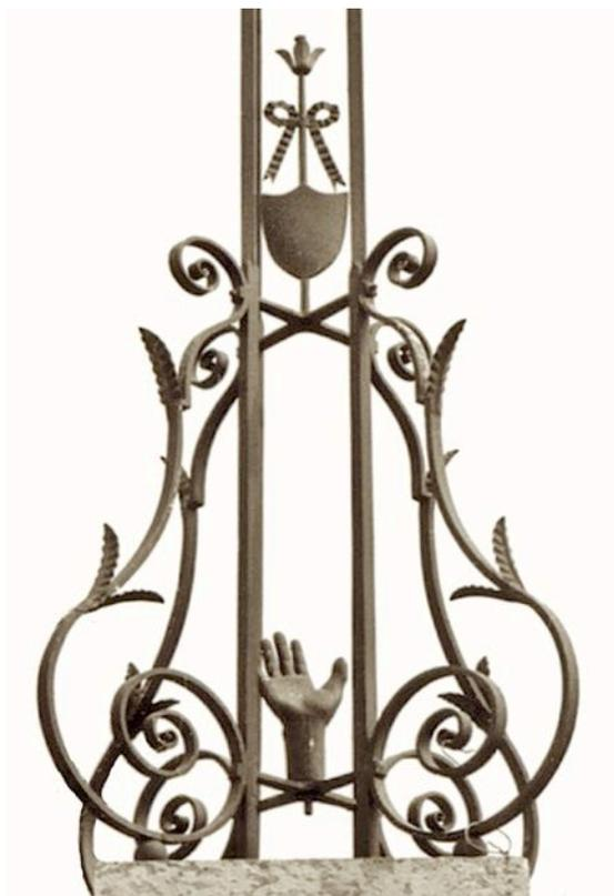
La structure est rigidifiée grâce à deux croisillons d'entretoisement en X positionnés au niveau des points d'attache des consoles (assemblage par simple boulonnage).
