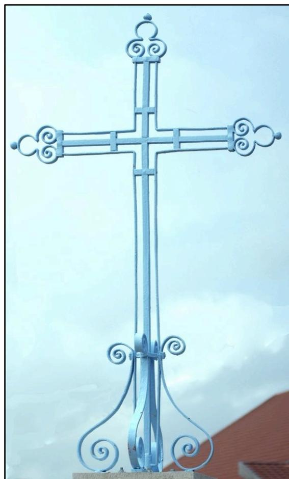
La croix en fer forgé est construite à partir d'un fer structurel porteur (croix 1D), de forte section carrée, présent également dans la traverse horizontale de la croix (fer vertical et fer horizontal étant assemblés à mi-fer).
