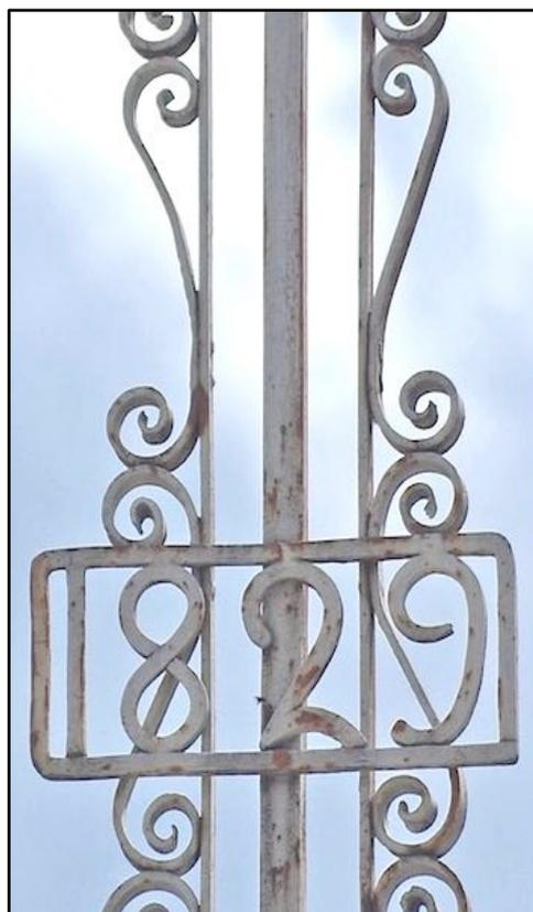
Deux duos de S ferronnés sont disposés le long du fût-pied (avec opposition de leurs rouleaux). Ils sont fixés aux longs fers latéraux par de discrets rivets.
