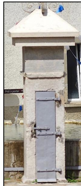
Le socle-piédestal de la croix constitue une sorte de coffre en pierre contenant la tuyauterie et le mécanisme d'une fontaine. Celle-ci déverse son eau dans le bassin hexagonal par la face avant. Une porte en fer est placée à l'arrière du monument.
