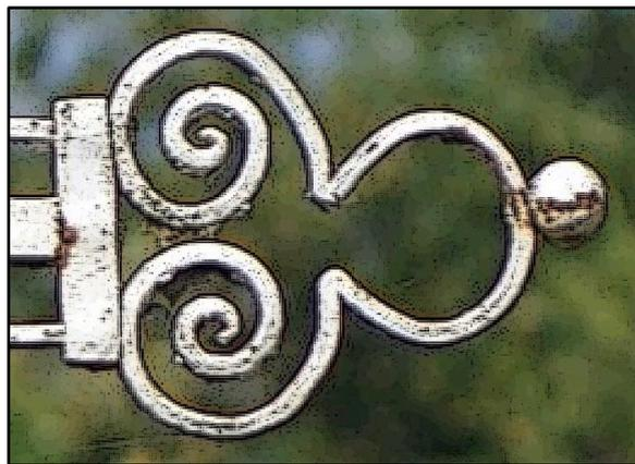
Dans les quatre angles des branches du croisillon sont placés des motifs de ferronnerie constitués de deux fers plats en C et à volutes, couplés et se terminant chacun par des enroulements de sens opposés. De discrets rivets permettent les fixations des différents fers
