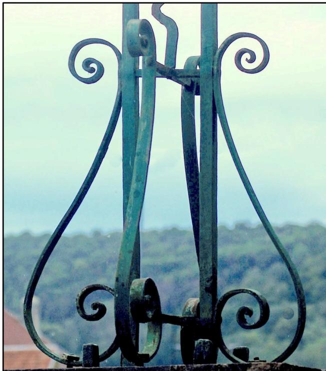
Placées sur les axes principaux de la croix, ces consoles comportent de beaux enroulements (plus gros en bas qu'en haut). Le dessin des consoles est assez souple et élégant. Les gros rouleaux du bas sont fixés au tailloir en pierre par des boulons alors que les deux montants structurels du fût y sont scellés.
