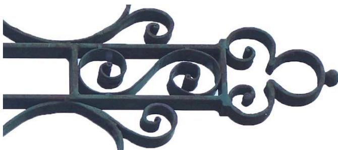
Des entretoises intermédiaires et des platines d'extrémité délimitent des espaces rectangulaires qu'occupent de beaux motifs en fer plat en forme de S. Les platines d'extrémités des branches assurant la terminaison des fers structurels servent aussi à fixer les trilobes.
