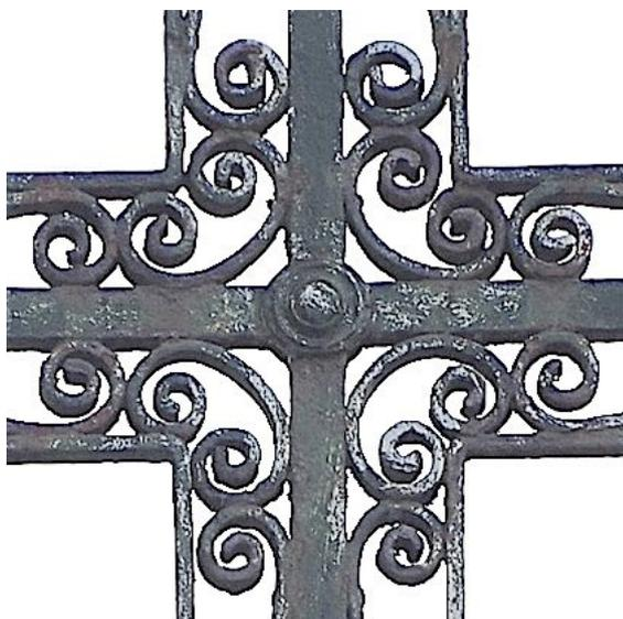
À la croisée des branches, les deux gros fers structurels sont assemblés à mi-fer ; une coupelle avec axe (vis ou rivet) assure le blocage de la fixation.
