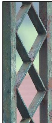
Ce décor se présente, visuellement, sous forme d'un treillis de carrés (losanges) et de triangles ou encore sous forme d'une frise de pseudo-losanges. Il s'agit, en fait, de deux fers plats allongés qui se croisent un certain nombre de fois (avec assemblage à mi-fer).
