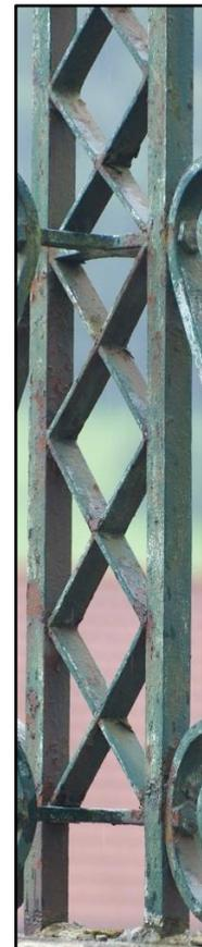
C'est un décor en fer plat forgé assez courant dans les années 1830-1850, surtout dans le secteur de Poligny (croix de type "polinois"). On relève, en bas, un premier ensemble en treillis constitué de deux lignes à 3 segments se croisant (soit au total 2 losanges et 2 demi-losanges).
