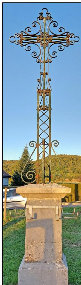
Cette grande croix est quelque peu atypique, par sa structure superposant deux étages ou modules très différents. Sur un pied ou fût à structure bidimensionnelle 2D et à décor de remplissage à treillis de losanges, s'élève un croisillon à structure unidimensionnelle 1D avec des duos de fers bordiers rectilignes et aussi avec un décor de fers en courbes et volutes.
