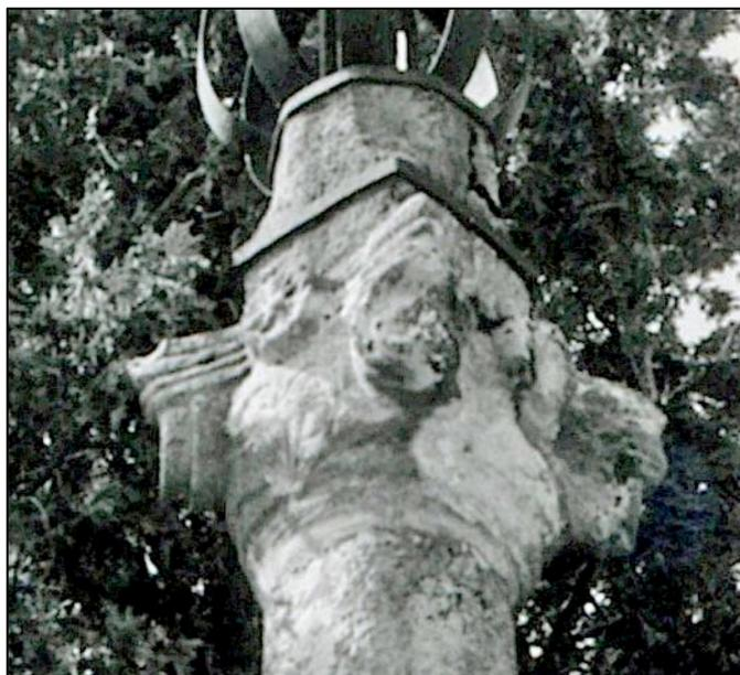
Il faut noter la présence d'un double cerclage en fer forgé (l'un carré, l'autre octogonal), assurant le maintien en bon état de la pierre au sommet de la colonne et permettant vraisemblablement aussi la fixation de la croix en fer forgé. Peut-être ce dé et son dispositif de cerclage ont-ils été ajoutés pour assurer la fixation et le maintien du croisillon en fer sur une colonne de pierre plus ancienne.
