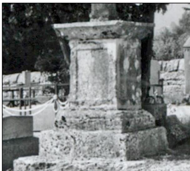
Le piédestal repose sur un emmarchement de dalles calcaires rectangulaires comportant une marche, ou peut-être deux, la plus haute pouvant être aussi considérée comme une première plinthe de la base du piédestal.
