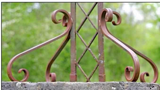
Les consoles actuelles, modernes, en ont remplacé de plus anciennes. Réalisées à partir de deux fers de section carrée, accolés et soudés entre eux en plusieurs points, elles adoptent le classique dessin en forme de S avec volutes d'extrémités au sens d'enroulement opposé. Ces consoles modernes ont été soudées à l'arc sur les montants structurels.
