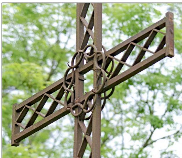
À chaque extrémité de branche, aux montants structurels parallèles vient se fixer une barrette de section rectangulaire qui assure la liaison mécanique entre les fers et la fermeture de la branche.
