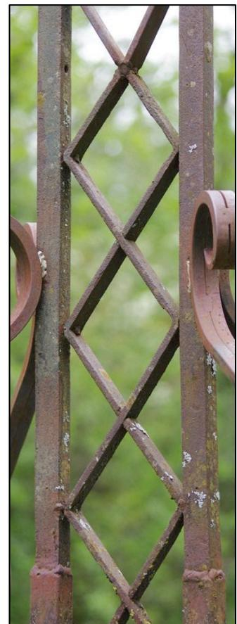
À noter que les frises à pseudo-losanges sont maintenues en place dans l'intervalle entre barres structurales grâce à de petites goupilles et à des rivets (à peine visibles) aux extrémités des branches ainsi qu'au niveau de la croisée (photo ci-contre).
