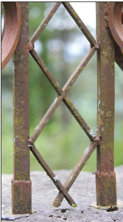
Le décor placé entre les deux fers structurels est constitué d'une frise d'apparents losanges. Il s'agit, en fait, de "pseudo-losanges", la frise étant réalisée grâce à deux barres en fer plat multi-pliées ou multi-coudées (dessin en zig-zag).
