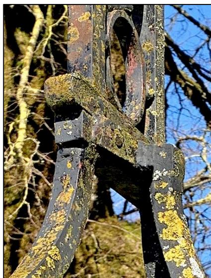
Alors que les fers des deux consoles latérales viennent se fixer à la barrette inférieure par le dessous, le fer de la console-arrière est lié à cette barrette inférieure, sur la face arrière de celle-ci, par le biais d'une petite patte horizontale. Les assemblages des fers semblent être réalisés par rivetage.
