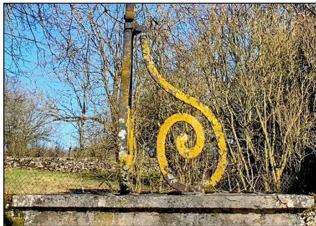
L'assemblage entre la base aux consoles et le pied du croisillon est réalisé par l'intermédiaire de deux barrettes en fer carré, solidarisées et présentant un léger débord.
