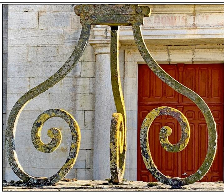
On est en présence d'un cas très rare de dispositif de soutien à trois consoles pour une croix en fer forgé, avec deux consoles latérales dans le plan principal de la croix et une console "arrière" assurant la stabilité de la croix au renversement.
