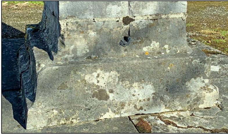
Au-dessus de l'embranchement, la base du piédestal, de plan carré, comporte un régllet surmonté d'une doucine renversée. Puis, après un fort retrait, elle vient s'ajuster sur le dé par l'intermédiaire d'une plinthe dotée d'un petit cavet renversé.
