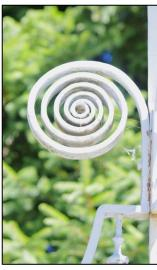
Le travail de fer forgé pour la réalisation des rouleaux des consoles est plutôt étonnant et assez rare dans le corpus des croix en fer forgé du Jura et du Doubs.
