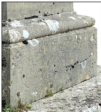
Le dé ou corps principal du piédestal est un parallélépipède de section carrée ne présentant aucune moulure.
