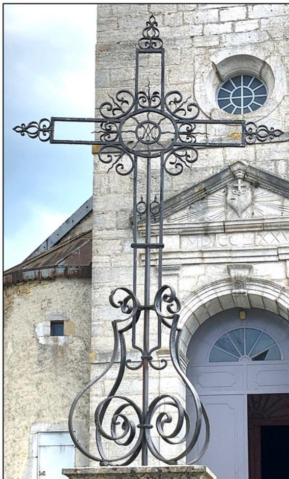
La croix métallique de Bief-du-Fourg est constituée, en partie basse, d'un pied à structure unidimensionnelle (1D) renforcé par quatre puissantes consoles. Ce pied se développe autour d'une tige ou montant unique en fer carré de large section. En partie haute de la croix, le pied est surmonté d'un croisillon très élancé et strictement plan, bidimensionnel (2D).
