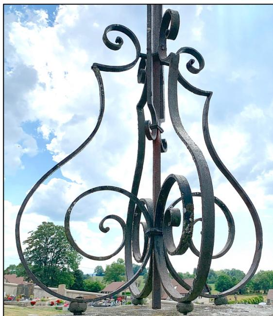
Les consoles, en fer plat, sont en forme de S avec de gros enroulements à la base et de plus petits (volutes) en hauteur.
