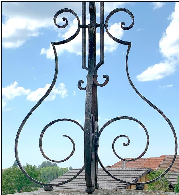
Ces élégantes consoles sont positionnées sur les diagonales de la corniche pour assurer une meilleure stabilité du monument (NB : à Boujailles, les consoles ne sont pas placées sur les diagonales de la corniche, mais sur les axes principaux du piédestal et de la croix métallique).
