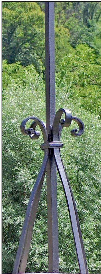
Quatre consoles placées sur les axes principaux de la croix (et non sur les diagonales du piédestal) assurent la stabilisation de la croix au renversement. Réalisées en fer plat et de forme simple, elles sont scellés en bas dans la pierre du socle.
